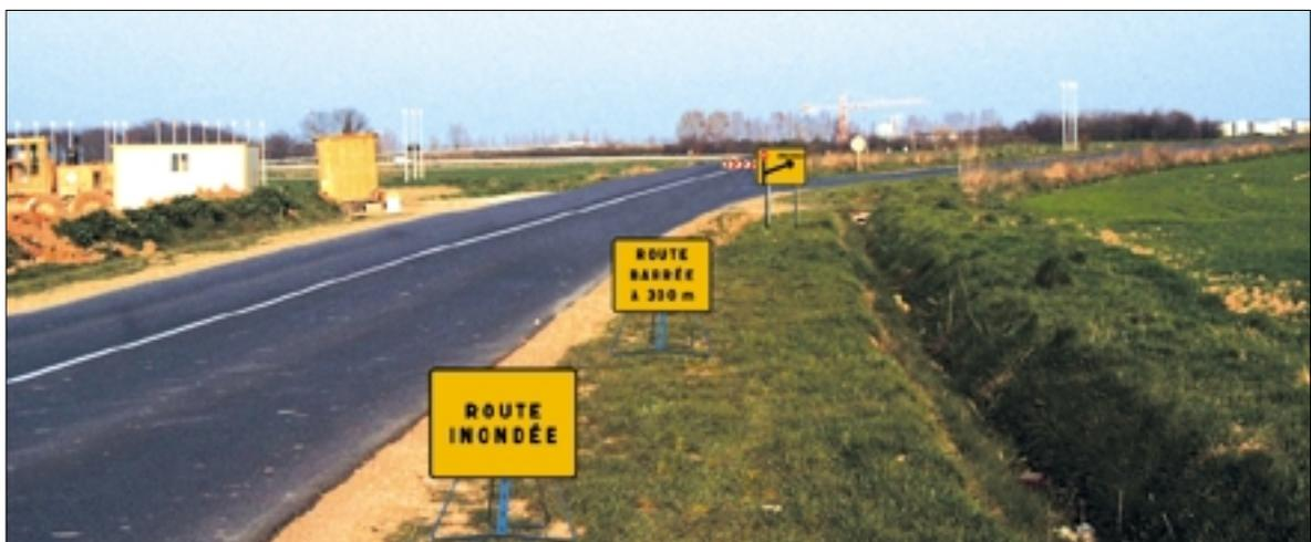
Mise en place d'une déviation à cause d'une inondation : séquence de présignalisation.
