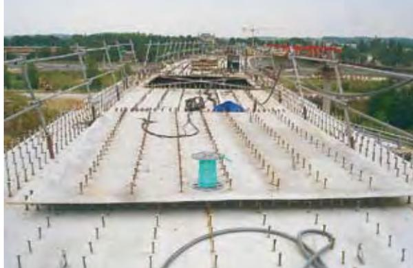
Photo 9 : une tôle coffrante étanche avant la pose (joint en vert)
