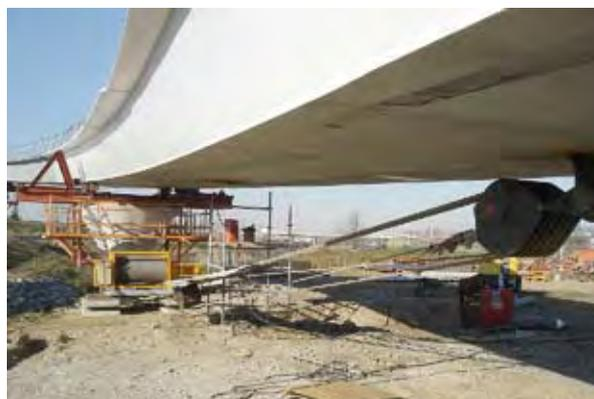
Photo 12 : chevêtre et guidage sur pile, treuil de retenue
