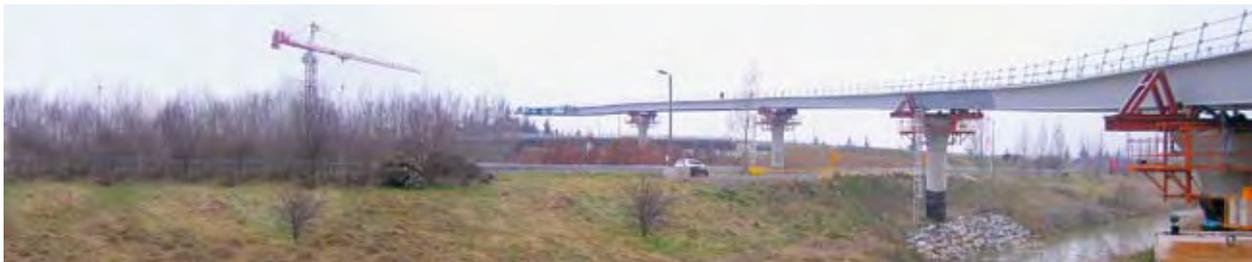
Photo 14 : 5<sup>ème</sup> phase de lancement côté est, approche de P3 - Source : SGT/DDE 31
