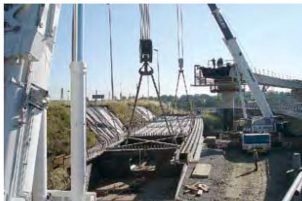
Photo 18 : grutage du tronçon central – Source : SGT/DDE 31
