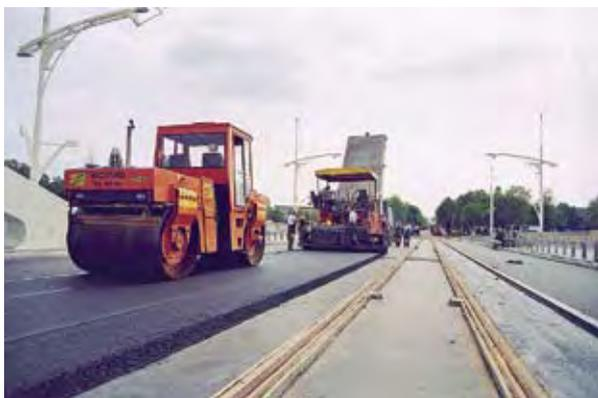
Photo 4 : mise en œuvre du Bétoflex par finisseur. On distingue les différentes parties du profil en travers ; en partant de la droite : la chaussée circulée, ensuite la voie de bus en site propre en partie sur la voie de tramway et la partie centrale – Source : Colas
