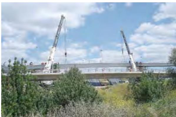
Photo 19 : grutage du tronçon central – Source : SGT/DDE 31
