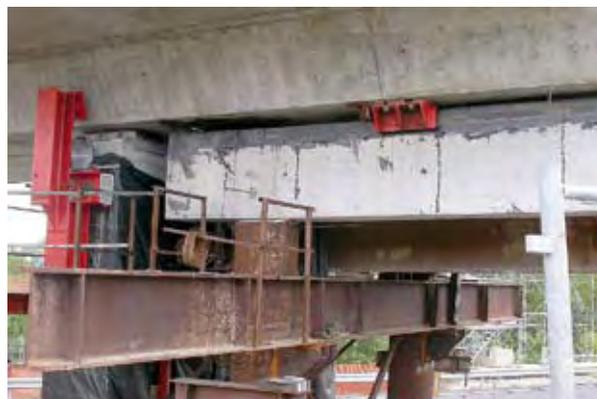
Photo 27 : guidages du tablier – Source : SGT/DDE 31
