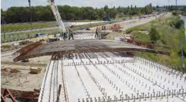
Photo 21 : chariotage des cages d'armatures – Source : SGT/DDE 31
