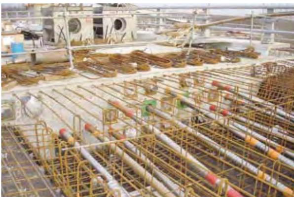
Photo 30 : raboutage des câbles entre partie poussée et coulée en place – Source : SGT/DDE 31
