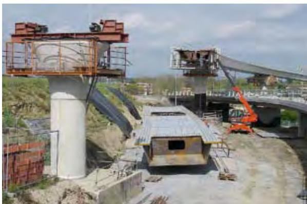
Photo 17 : tronçon central au sol – Source : SGT/DDE 31
