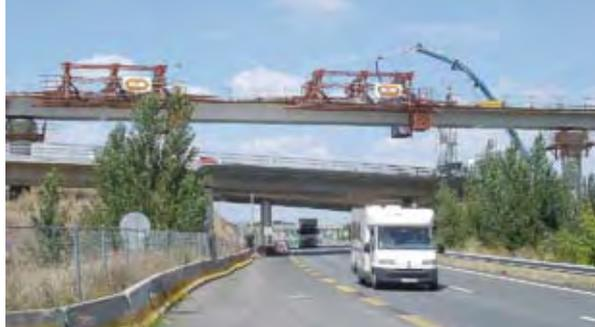
Photo 22 : bétonnage d'un plot – Source : SGT/DDE 31
