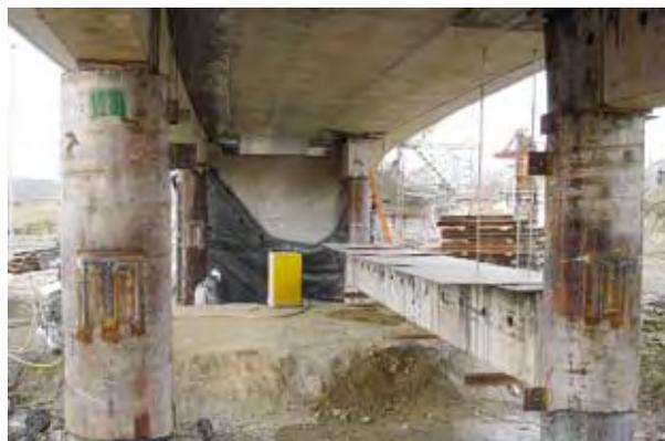
Photo 31 : dépose des longrines de poussage – Source : SGT/DDE 31
