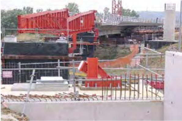
Photo 28 : poussage de la partie est – Source : SGT/DDE 31
