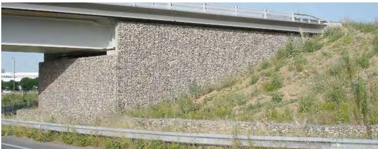
Photo 2 : parements « grillage-cailloux » de l'OA-DE – Source : SGT/DDE 31
