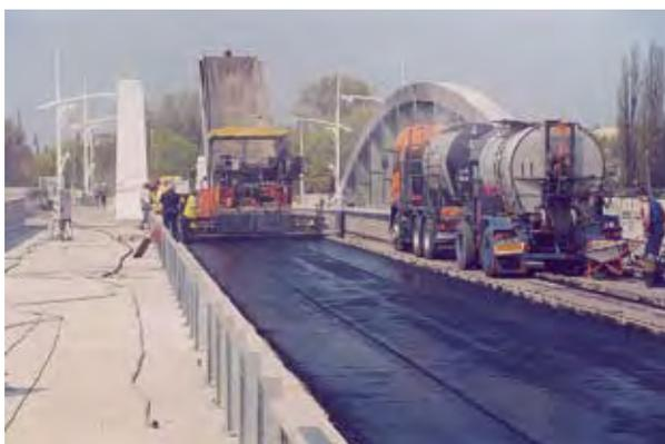
Photo 3 : mise en œuvre de la couche de Safflex par finisseur (à noter le chantier d'application de l'asphalte, amené par pétrin chauffant, entre les rails dans la partie centrale) – Source : Colas
