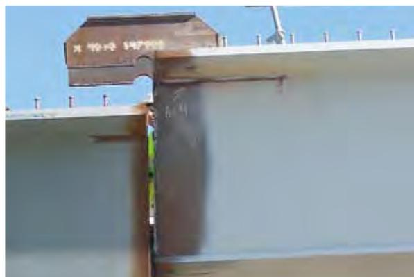
Photo 20 : clames de repos provisoire du tronçon central – Source : SGT/DDE 31
