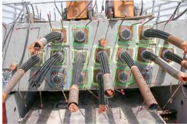
Photo 29 : about arrière phase est (coupleurs en bleu) – Source : SGT/DDE 31
