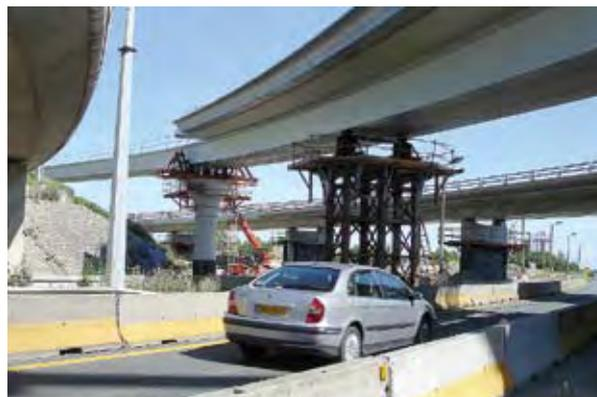
Photo 16 : dernier lançage avec la dalle – Source : SGT/DDE 31
