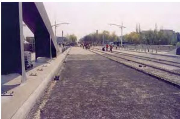
Photo 2 : vue du chantier avec, en premier plan, la partie acier ayant reçu la couche de résine époxydique gravillonnée (par projection au pistolet) et, au second plan, la partie béton avec son étanchéité par feuille bitumineuse préfabriquée posée par soudage en plein au chalumeau – Source : Colas
