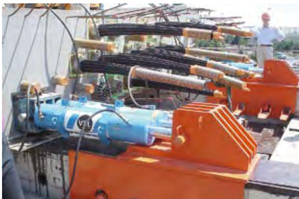
Photo 26 : vérin pousseur – Source : SGT/DDE 31
