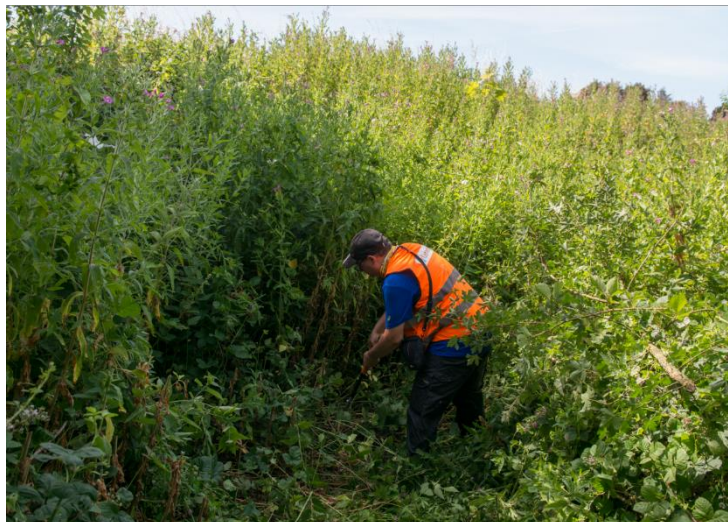
Figure 98 : photo montrant la coupe de la végétation depuis l'ouverture de l'ouvrage de franchissement jusqu'en haut du talus pour favoriser le passage des animaux. Photo : cc-by-sa-3 O. Pichard
