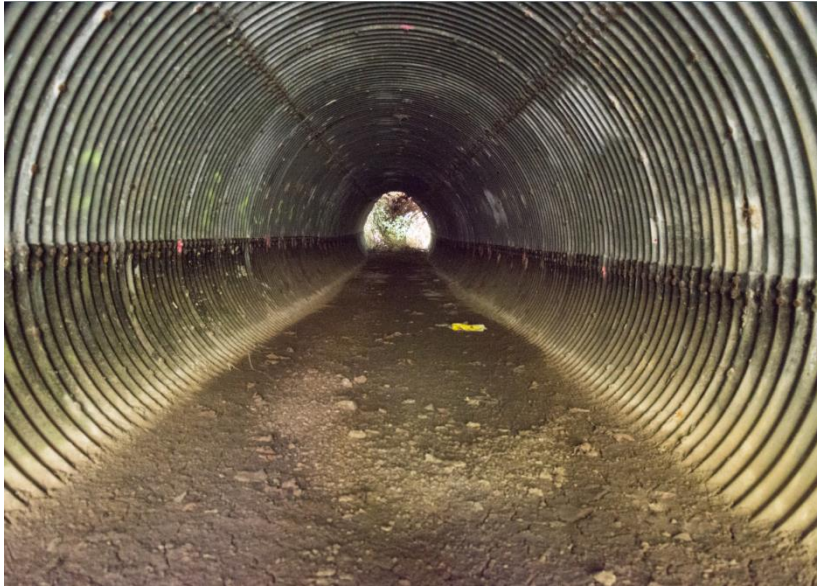
Figure 94 : photo montrant l'intérieur de la buse métallique avec un sol en terre végétale. Photo cc-by-sa-3 O. Pichard
