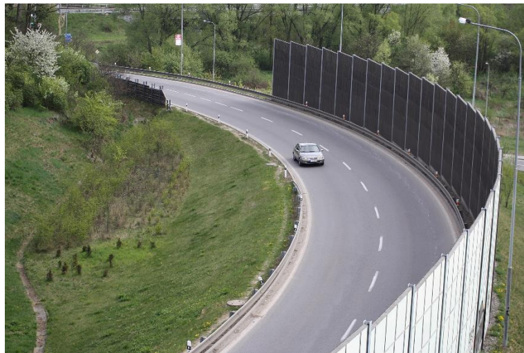
Figure 41 : Mise en place de murs anti-bruit pour réduire le bruit provenant de la route (Source : CC-BY-SA, Frettie)
