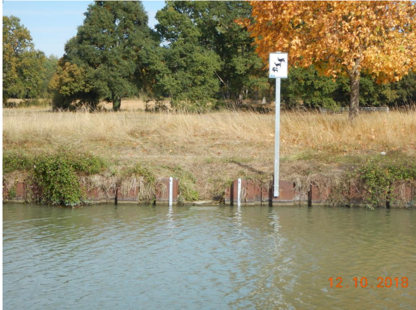
Figure 30 : Entaille réalisée dans des palplanches métalliques le long d'un canal pour permettre à la faune de s'échapper en évitant la noyade (source : VNF direction territoriale Centre Bourgogne)
