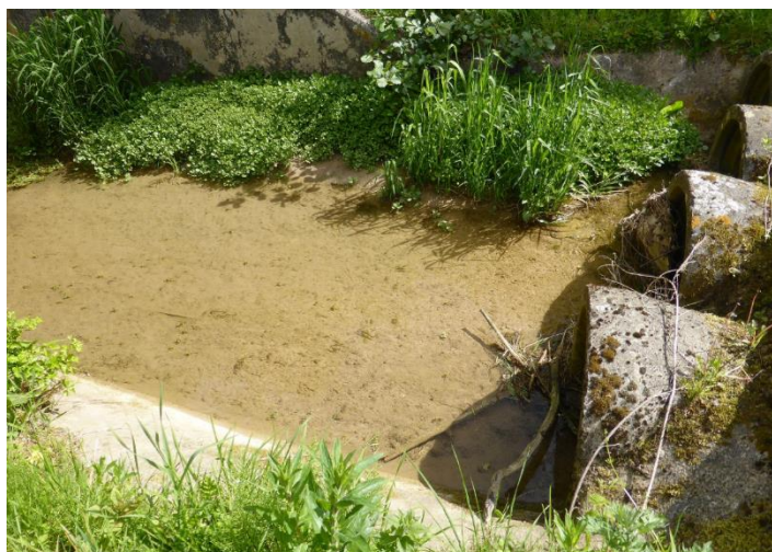
Figure 107 : Présence de 4 buses hydrauliques à la sortie sud de l'ouvrage de franchissement pour permettre le franchissement du cours d'eau par un chemin parallèle à la RN42. Photo : cc-by-sa-3 F. Fournier
