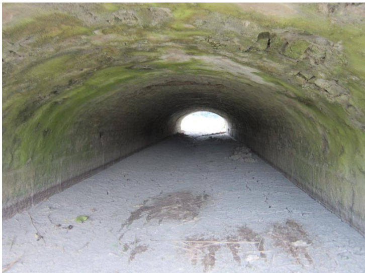
Figure 75 : vue de l'intérieur de l'ouvrage de franchissement en passage inférieur. photo : J. Bacquaert, CD62
