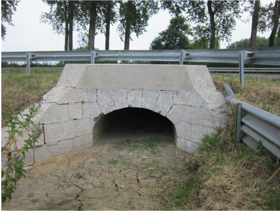
Figure 74 : vue sur l'ouvrage de franchissement en passage inférieur. photo : J. Bacquaert, CD62
