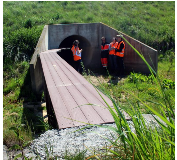
Figure 35 : Buse hydraulique aménagée : en haut à gauche état initial, en bas à gauche création d'une banquette en encorbellement, en bas à droite banquette prolongée pour rester hors inondation sur toute sa longueur. Ouvrage OH46 sur RN42 section Hautmont-Beaufort (59) lieu-dit « sur le bois ». Source Cerema Nord-Picardie
