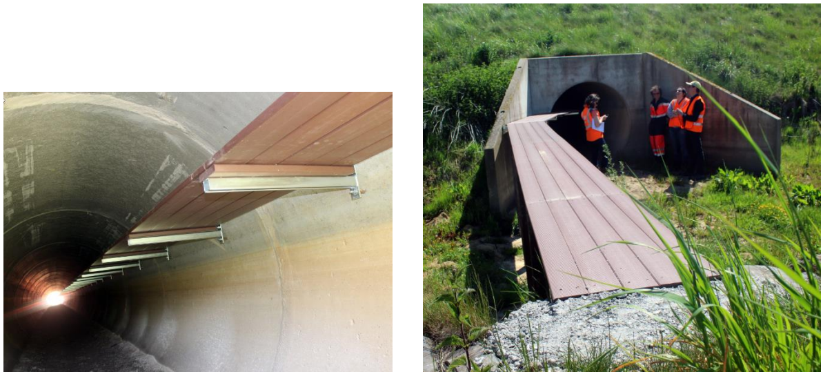
Figure 114 : Buse hydraulique aménagée : en bas à gauche création d'une banquette en encorbellement, en bas à droite banquette prolongée pour rester hors inondation sur toute sa longueur. Exemple de l'ouvrage OH46 sur RN42 section Hautmont-Beaufort (59) lieu-dit « sur le bois ». Source Cerema Nord-Picardie
