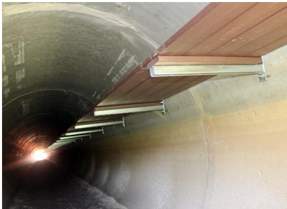
Figure 35 : Buse hydraulique aménagée : en haut à gauche état initial, en bas à gauche création d'une banquette en encorbellement, en bas à droite banquette prolongée pour rester hors inondation sur toute sa longueur. Ouvrage OH46 sur RN42 section Hautmont-Beaufort (59) lieu-dit « sur le bois ». Source Cerema Nord-Picardie
