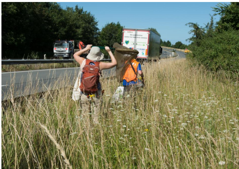
Figure 96 : photo montrant les glissières métalliques sur la RN42 et le continuum végétal long de celle-ci. Photo cc-by-sa-3 O. Pichard
