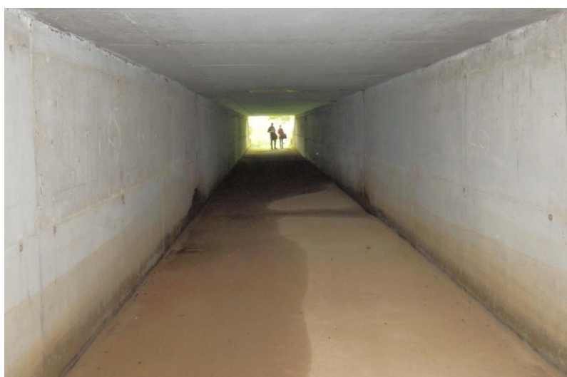
Figure 108 : photo montrant l'intérieur du dalot le 27/08/2018. Le ruisseau est quasiment à sec à cette période de l'année. Photo : cc-by-sa-3 F. Fournier
