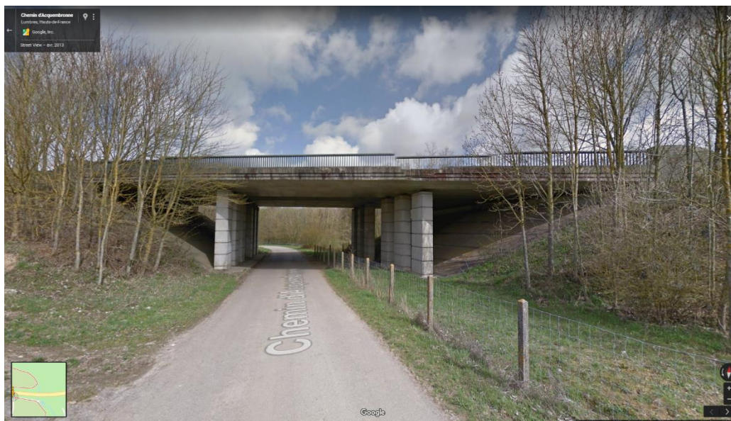
Figure 109 : Vue Google Street View montrant le chemin d'Acquembronne situé à 200 mètres à l'ouest de l'ouvrage de franchissement étudié. (Source : Street View – Date de l'image : avril 2013 ©2018 Google)
