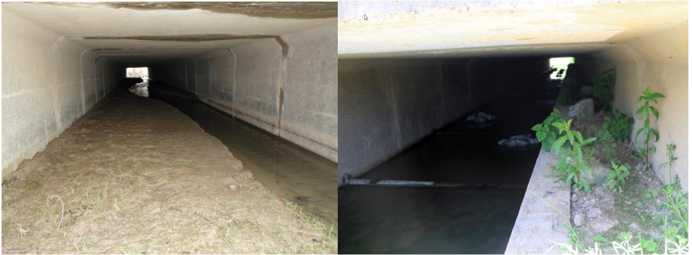
Figure 113 : Exemple d'aménagement réalisable : dalot du ruisseau « la couture » : à gauche avant travaux, à droite après travaux, création d'une banquette avec sol naturel reconstitué. RN 42 section Hautmont-Beaufort (59) source : Cerema Nord-Picardie
