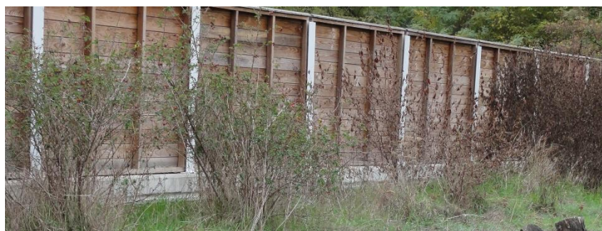
Figure 47 : Ecran visuel permettant d'éviter l'éclairage de l'ouvrage de franchissement par les phares des véhicules. Photo : cc-by-sa-3 O. Pichard
