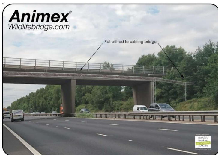
Figure 51 : structure métallique de marque animex fixée contre le tablier d'un ouvrage de franchissement d'une infrastructure. Ce type de structure a montré son efficacité pour le passage du muscardin et de l'écureuil roux (source Animex)
