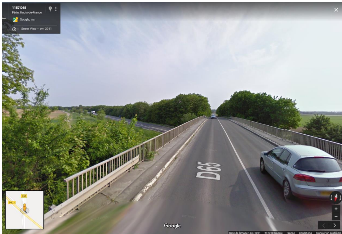
Figure 81 : extrait de carte Google Street View montrant l'ouvrage de franchissement D65 passant au-dessus de la RD 621. (Source : Street View – Date de l'image : avril 2011 ©2018 Google)
