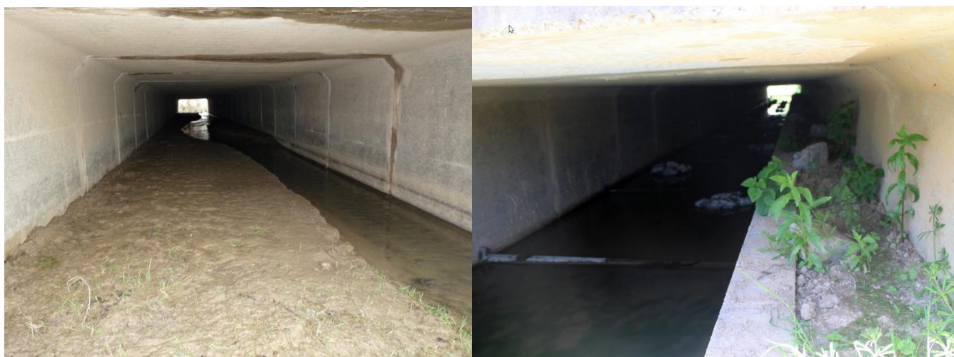
Figure 34 : Aménagement du dalot du ruisseau « la couture » : à gauche avant travaux, à droite après travaux, création d'une banquette avec sol naturel reconstitué. RN 42 section Hautmon-Beaufort (59) source : Cerema Nord-Picardie
