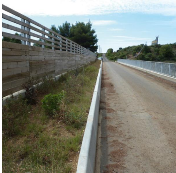
Figure 50 : trottoir rehaussé de 50 cm de haut permettant d'apporter du substrat naturel et de favoriser une végétalisation naturelle. Source : Ecologistes de l'Euzière in (Nowicki 2016)
