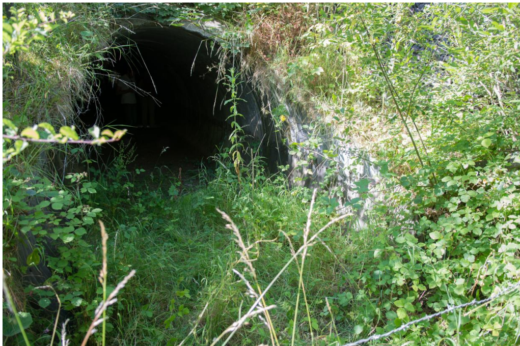
Figure 92 : Entrée de l'ouvrage inférieur côté nord de la RN42. Photo cc-by-sa-3 O. Pichard
