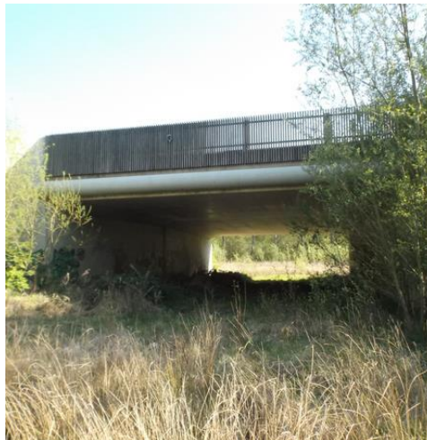
Figure 39 : Passage à faune avec un couloir végétal traversant le passage et de la végétation à l'entrée et sortie du passage. source Cerema Nord-Picardie
