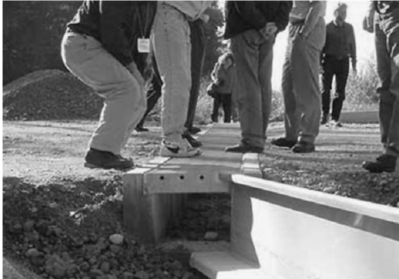
Figure 55 : Construction d'un batrachoduc à travers route aux États Unis Source : (Glista, DeVault, DeWoody 2009)
