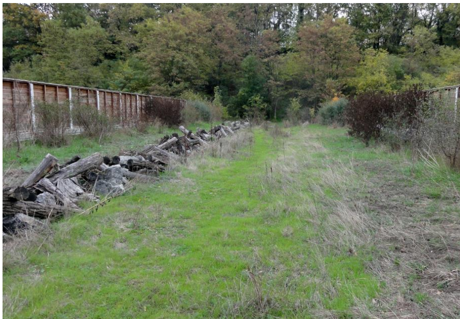
Figure 38 : Mise en place d'andains de bois mort servant d'habitat et de zones refuges pour la petite faune. Autoroute A 7, commune de Beausemblant – Photo cc-by-sa-3 O. Pichard
