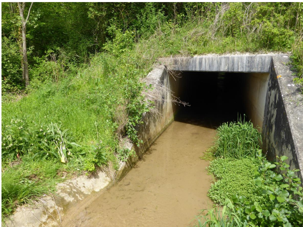
Figure 105 : Ouverture de l'ouvrage de rétablissement hydraulique du ruisseau d'Acquin au sud de la RN42. Photo : cc-by-sa-3 F. Fournier
