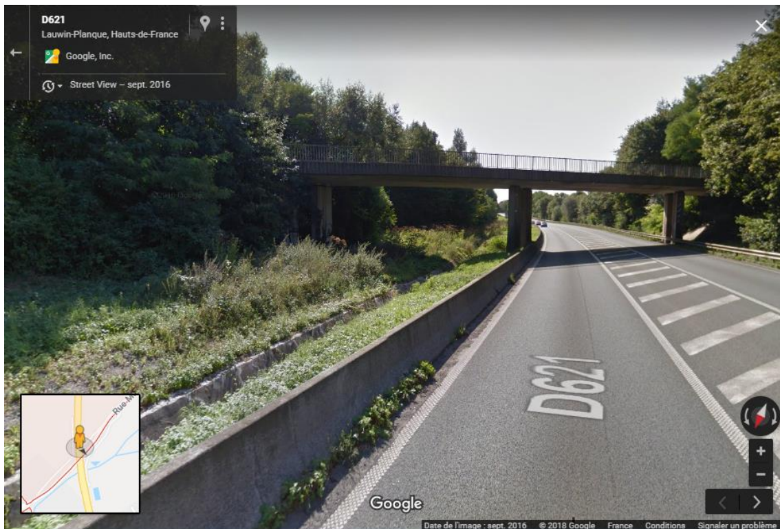
Figure 88 : extrait de carte Google Street View montrant la vue depuis la RD 621 sur l'ouvrage de franchissement « voie d'Esquerchin ». Vers l'est de la route, présence d'une glissière en béton armée et d'un fossé béton. (Source : Street View – Date de l'image : septembre 2016 ©2018 Google)
