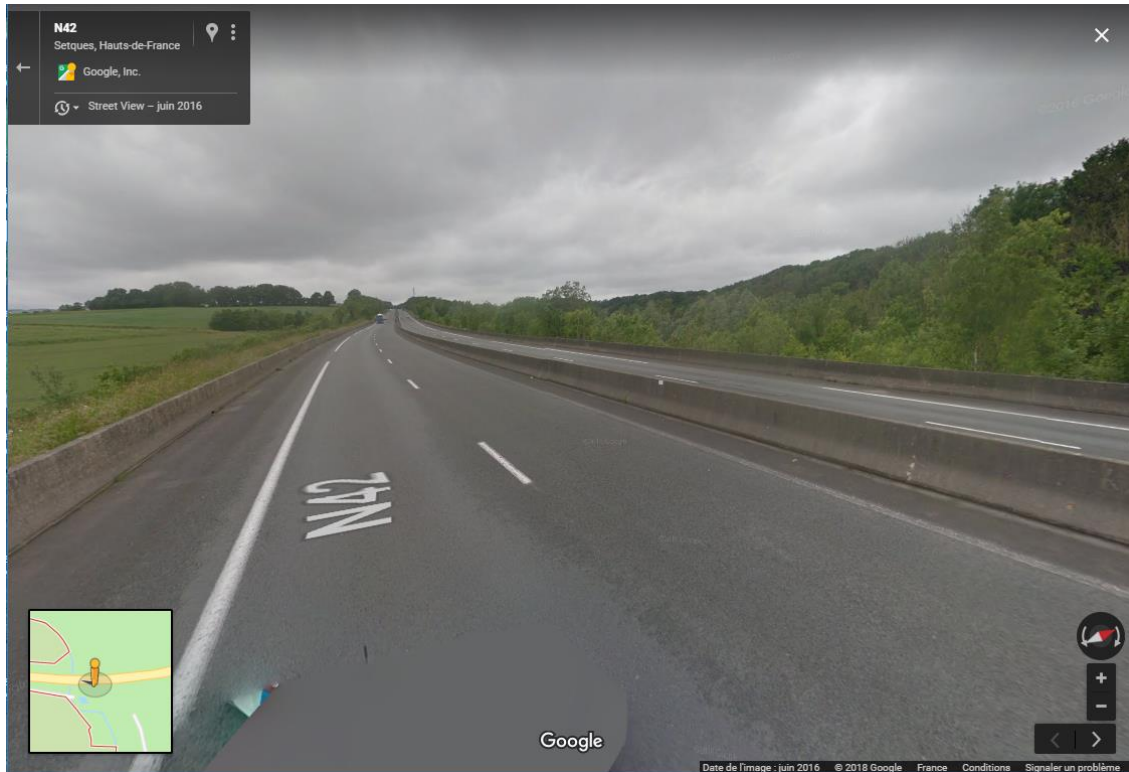
Figure 106 : Vue Google Street View montrant la N42 au-dessus de l'ouvrage de franchissement : des glissières en béton armé délimitent le terre-plein central et chacun des bords des deux voies. (Source : Street View – Date de l'image : juin 2016 ©2018 Google)
