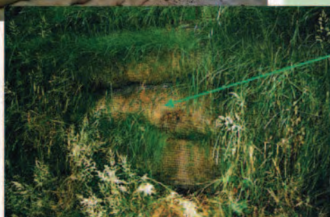
Mur en remblai renforcé par nappes géotextiles avec parement incliné et végétalisé
