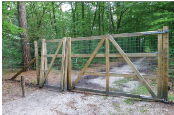
Figure 74 : Type de porte grillagée permettant de maintenir la possibilité aux véhicules à 4 roues d'utiliser la voie de desserte de l'autoroute
