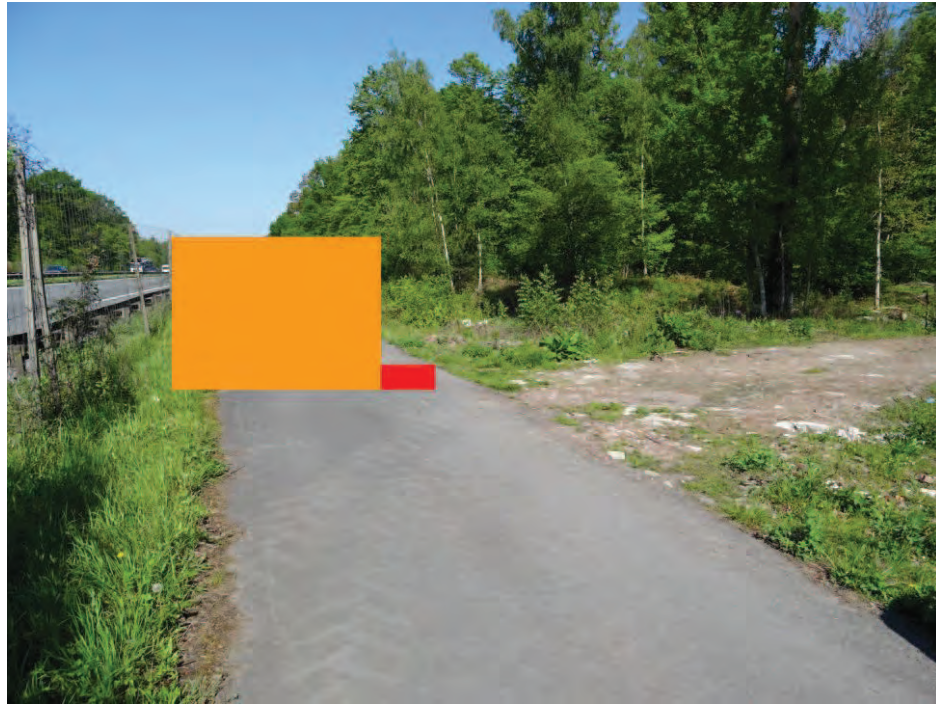
Figure 76 : Photo illustrant l'emplacement de la porte (orange) et de l'un des deux passages canadiens (en rouge) (côté Est). Photo M. Gilleron
