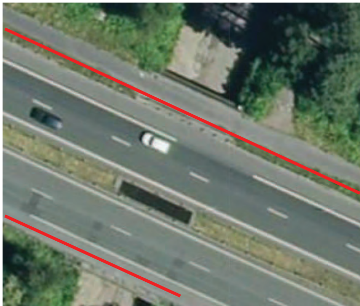
Figure 70 : Photo aérienne de la voie de desserte. En rouge, le grillage existant (source : Géoportail)
