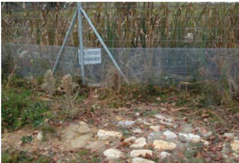
Figure 77 : Photo illustrant le principe de deux grillages accolées pour éviter le franchissement de la petite faune en partie basse. Photo M. Gilleron
