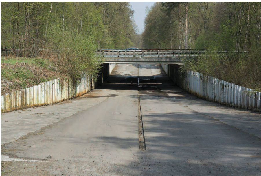
Figure 42 : Photographie du passage inférieur de la Drève de Bassy
