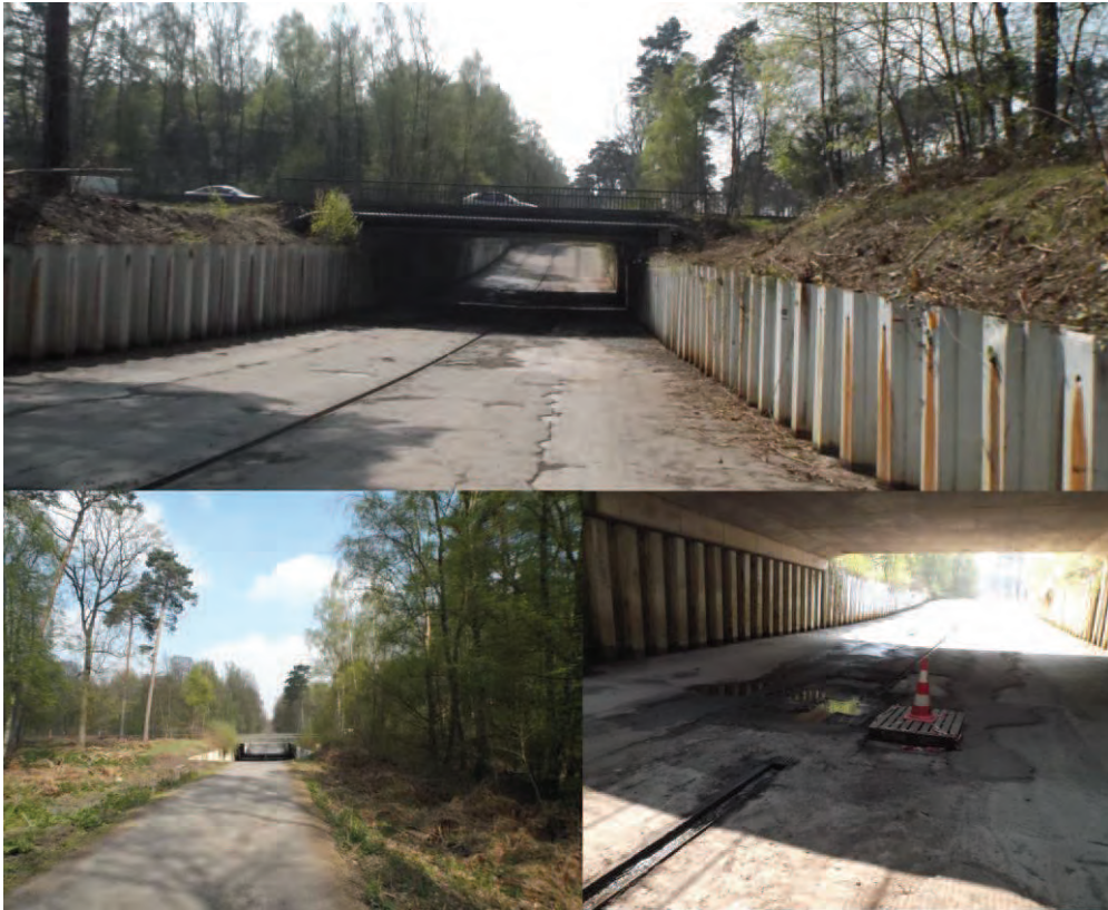
Figure 45 : Photographie du passage inférieur vue du Nord (en haut), vue du Sud (à gauche) et sous l'ouvrage (à droite)
