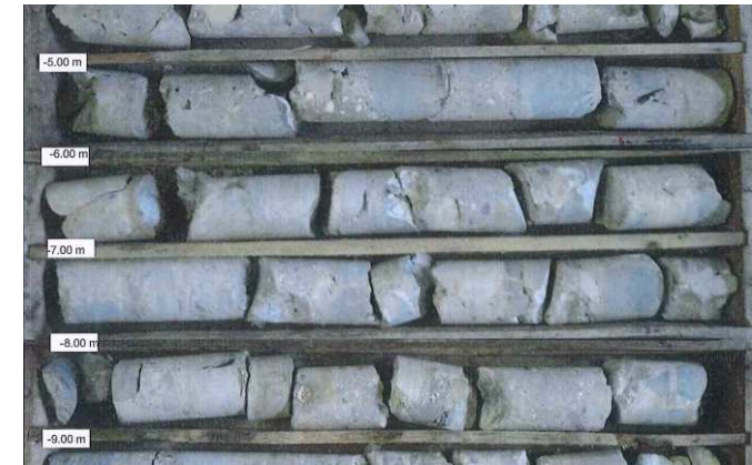
Sondages carottés dans gros béton de fondation
