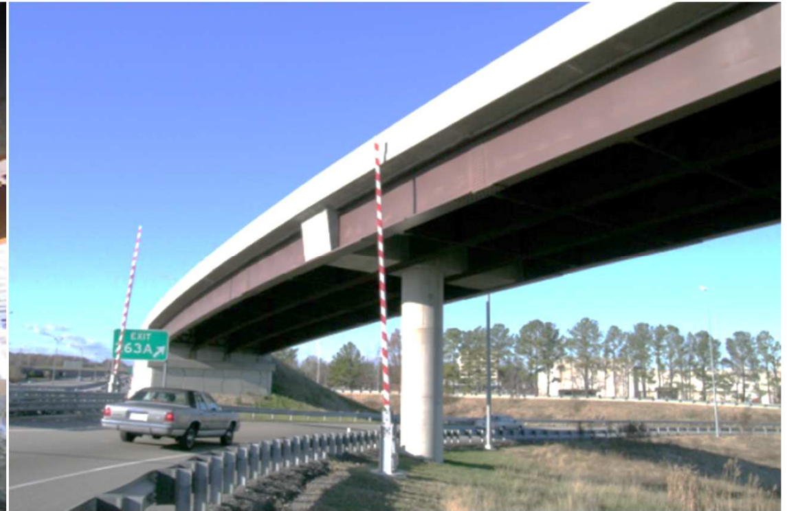
Pont intégral sur culée et piles
