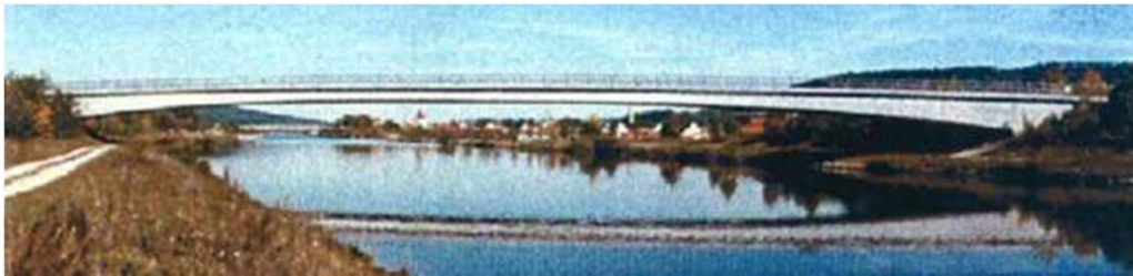
Southern Viaduct Berching – Portée de 106m50
