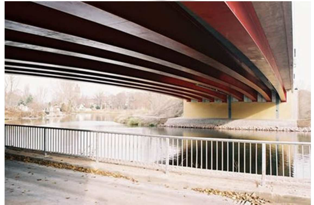
Pont sur la Saale à Merseburg – Portée de 55m40 Photo : SSF
