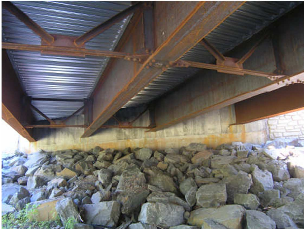
Exemple de pont à poutres métalliques
