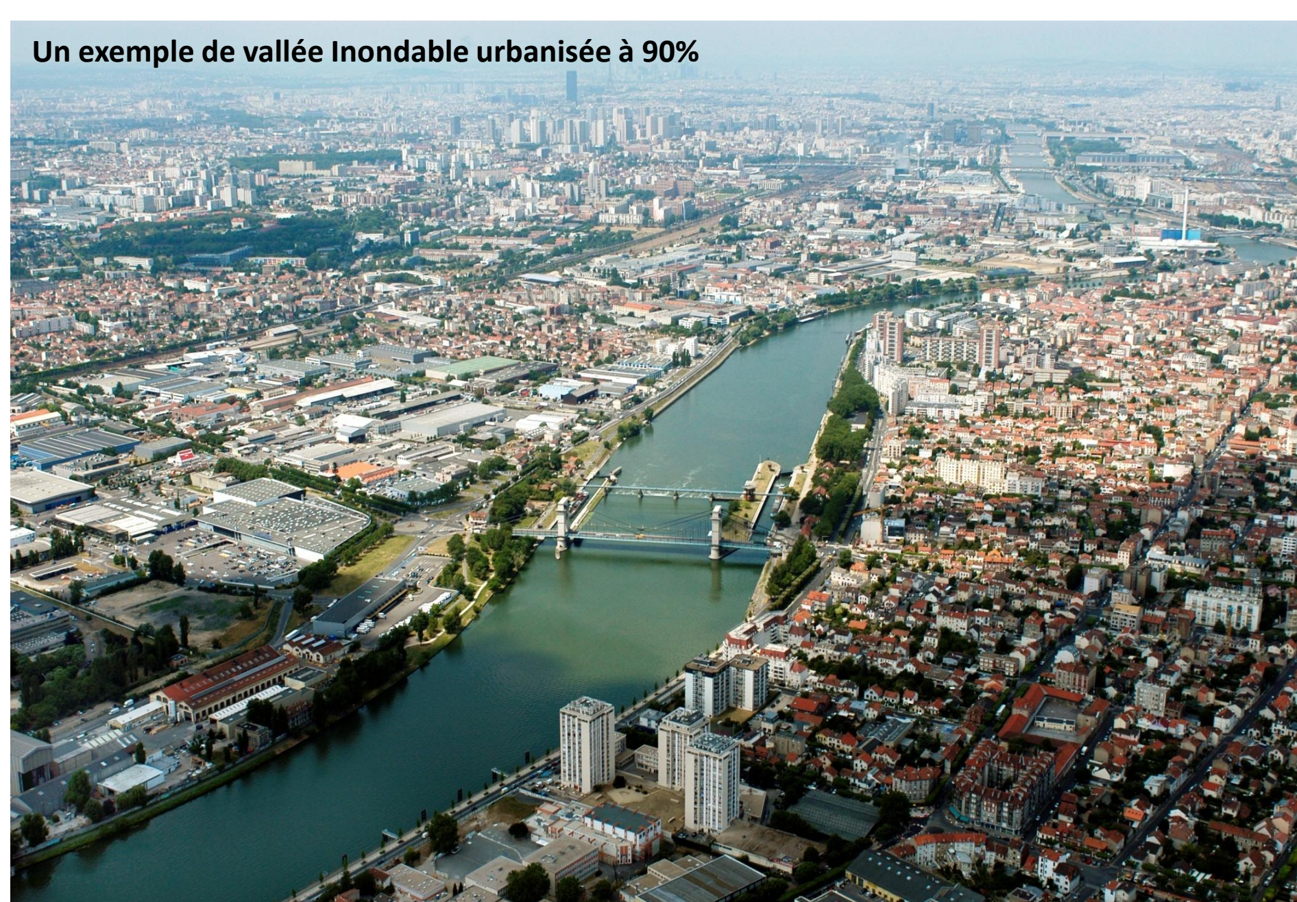
Alfortville, Vitry sur Seine, pont du Port à l'Anglais (panoramique) DREIF/GOBRY 03/07/2006
