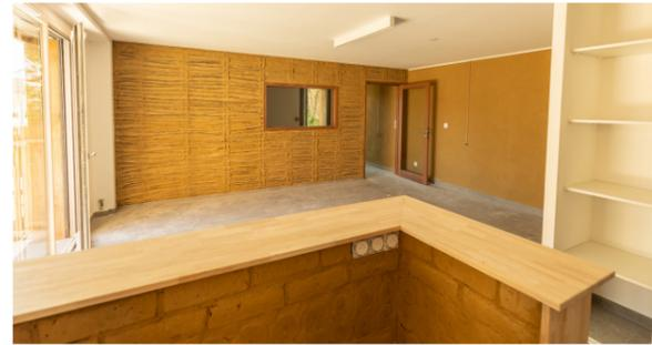
L'usage de la terre en circuit court, associé au bois en structure et d'autres matériaux biosourcés permettra de limiter significativement l'empreinte carbone du projet.
