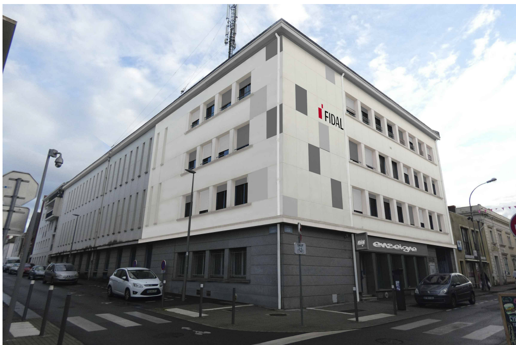
Façade après rénovation - SARL Rousseau Architecte
