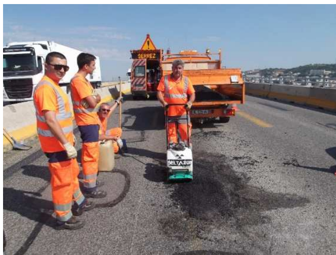
Petite réparation de chaussée
