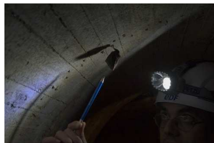
Inspection d'une galerie d'ouvrage d'art
