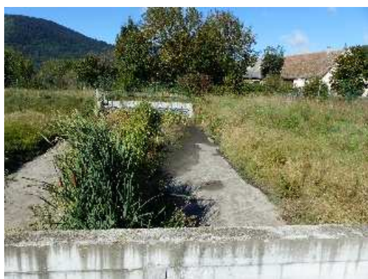
Bassin sur la RN85
