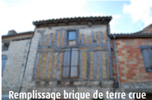
Remplissage brique de terre cuite
