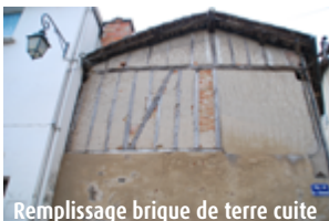
Remplissage brique de terre cuite
