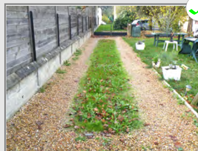
Revêtement stabilisé et bande centrale enherbée.
