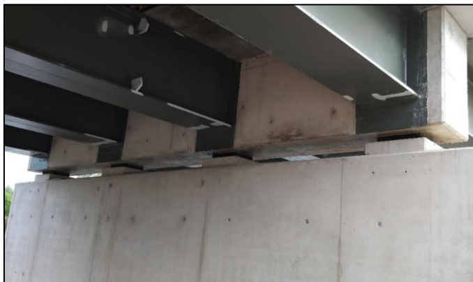
Figure n°33 : Vue d'une entretoise sur pile après décoffrage
