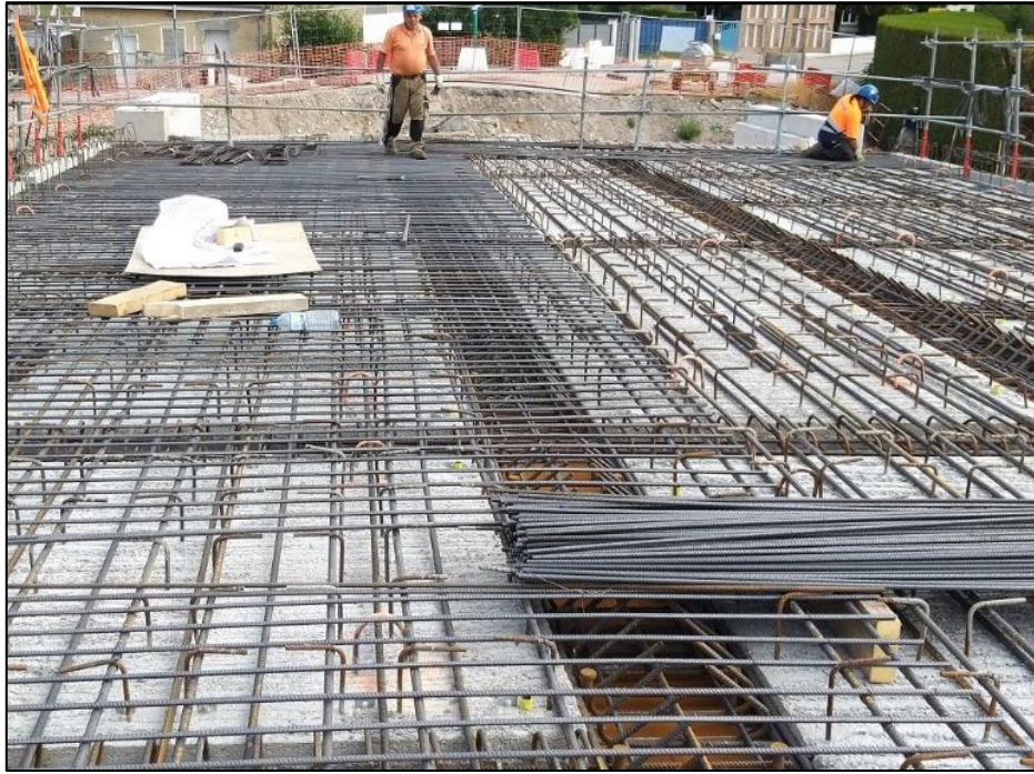
Figure n°30 : Vue générale du ferrailage supérieur du hourdis
