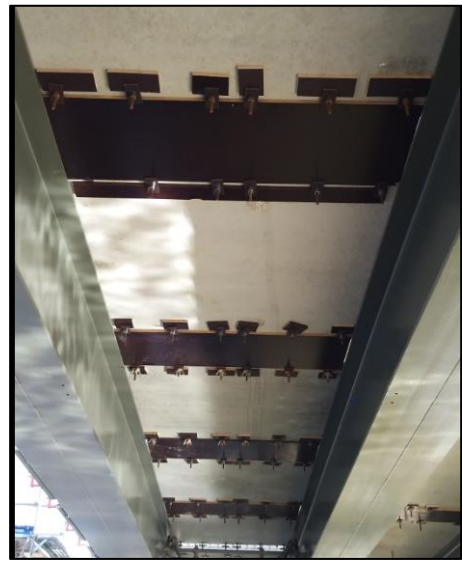
Figure n°32 : Vue du coffrage des clavages transversaux
