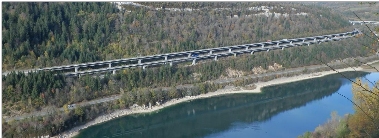
Figure n°1 : Vue d'ensemble de l'ouvrage
