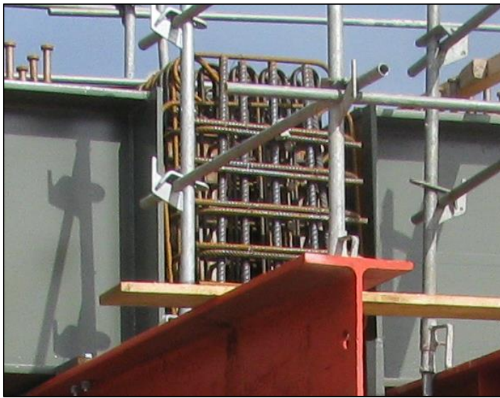
Figure n°31 : Détail du ferrailage d'une entretoise sur pile
