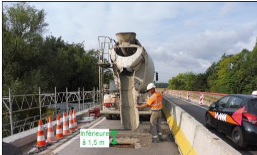
Figure n°8: Hauteur de chute du béton. Détermination possible par un agent à partir de vidéos ou. automatisé de la tâche .
