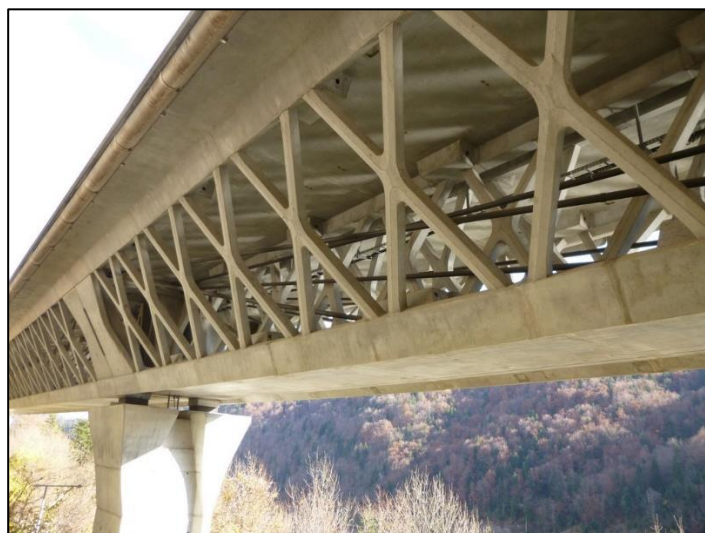
Figure n°2 : Vue rapprochée d'un des tabliers de l'ouvrage
