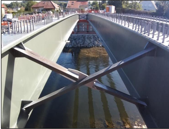
Figure n°26 : Vue des contreventements entre poutres
