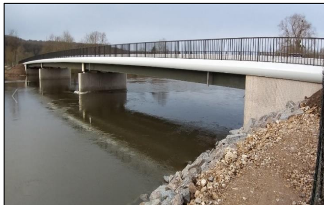
Figure n°34 : Vue de l'ouvrage terminé
