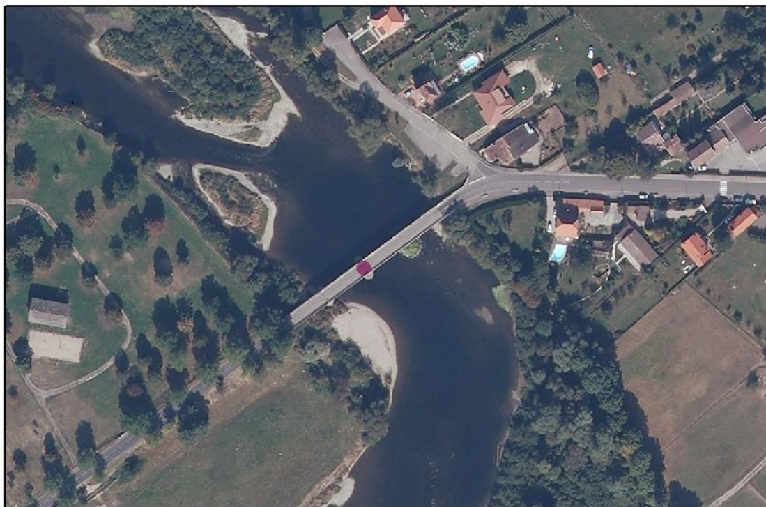
Figure n°1 : Vue aérienne de l'ancien ouvrage
