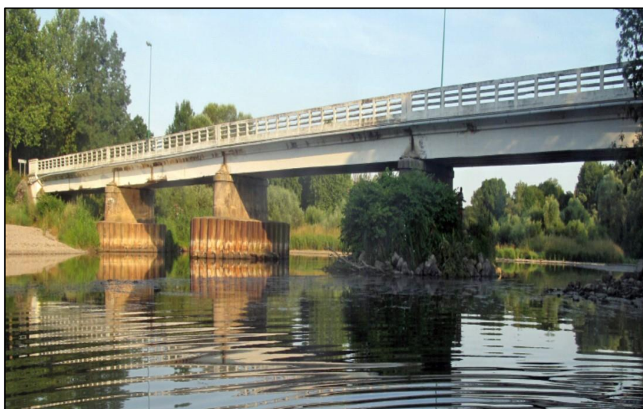
Figure n°2 : Vue générale de l'ancien ouvrage
