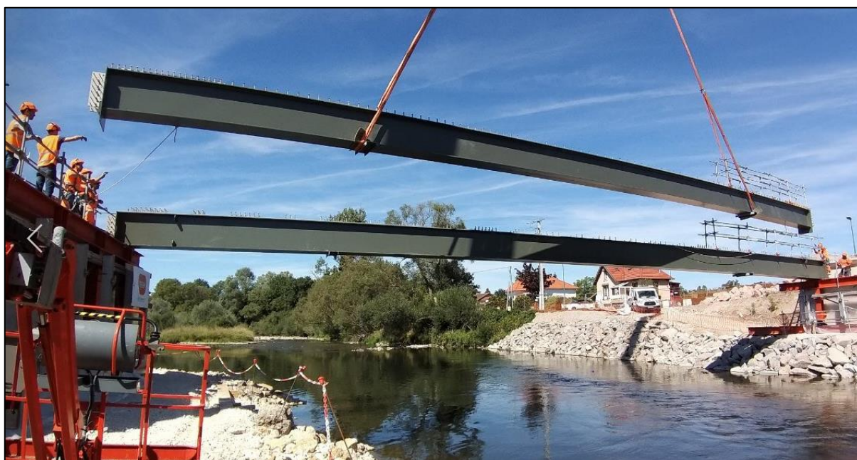
Figure n°23 : Pose des poutres à la grue sur les appuis provisoires
