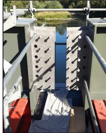
Figure n°27 : Détail d'about des poutres-caissons
