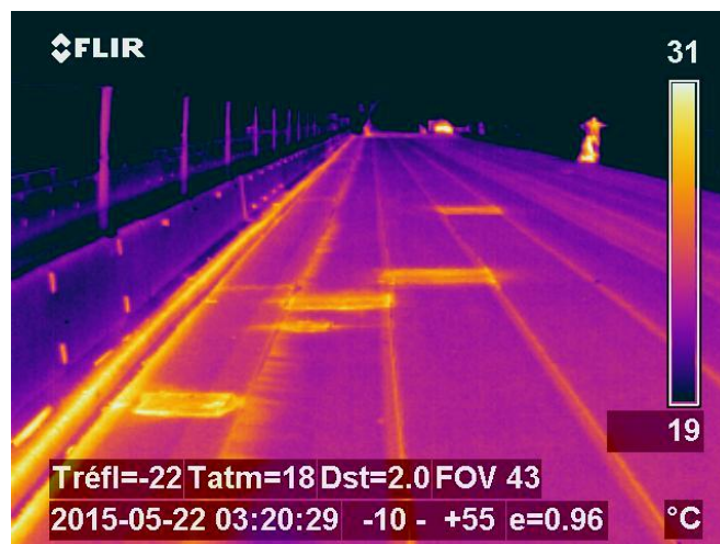
Figure n°3: Imagerie infrarouge sur ouvrage d'art
