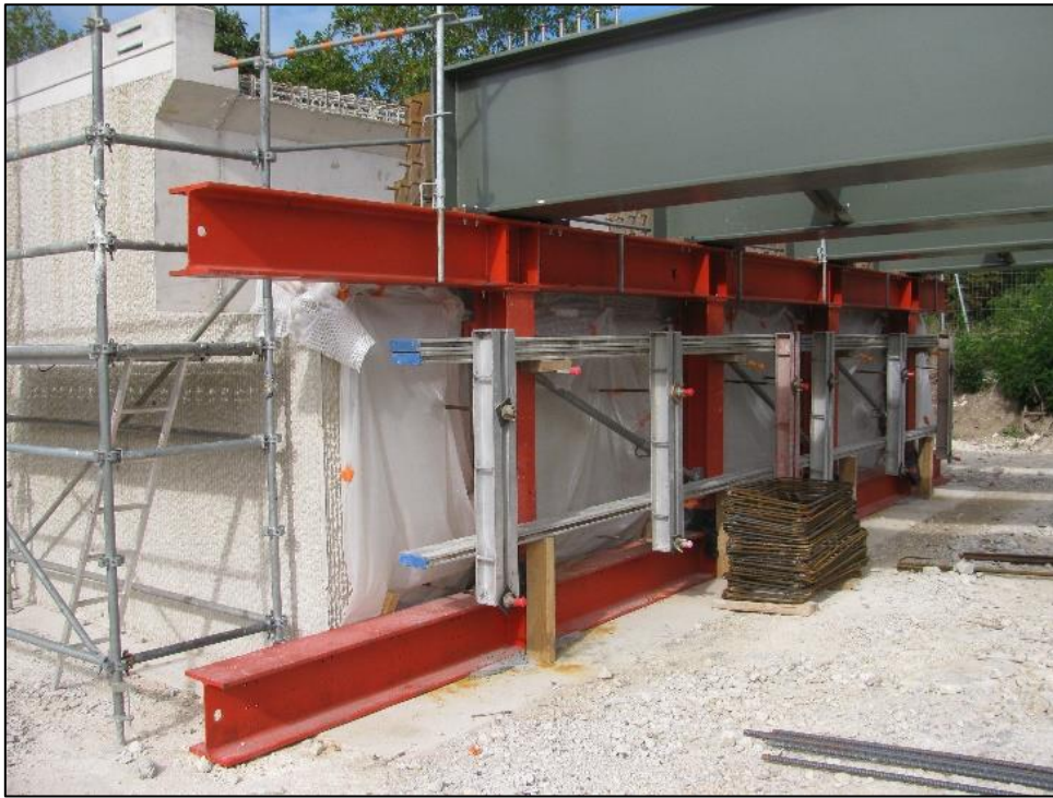
Figure n°24 : Vue des appuis provisoires devant une culée
