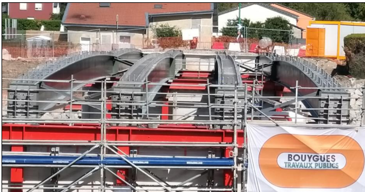
Figure n°25 : Vue des poutres posées sur les deux premières travées
