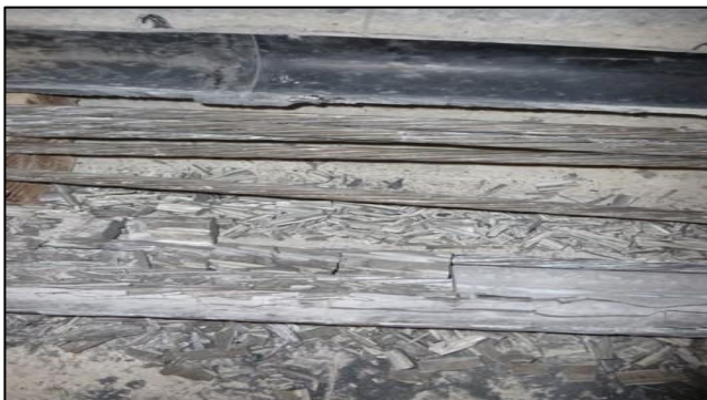
Figure n°27 : Bonne injection et torons sains
