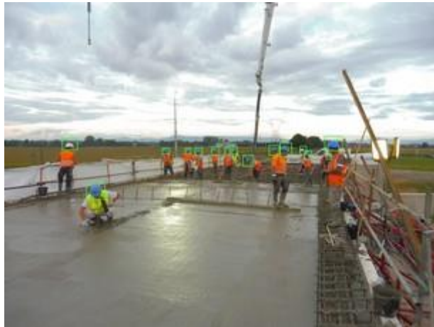
Figure n°1-b: Application potentielle de la reconnaissance de formes : détection de port de casques sur chantier.
