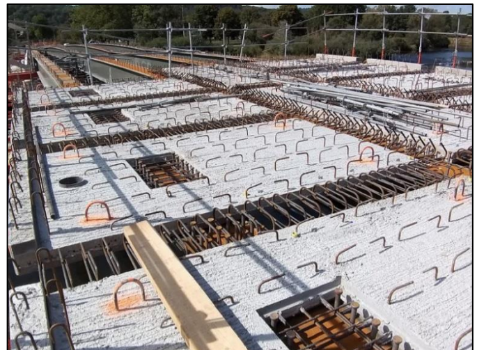
Figure n°29 : Vue générale des prédalles posées sur les poutres
