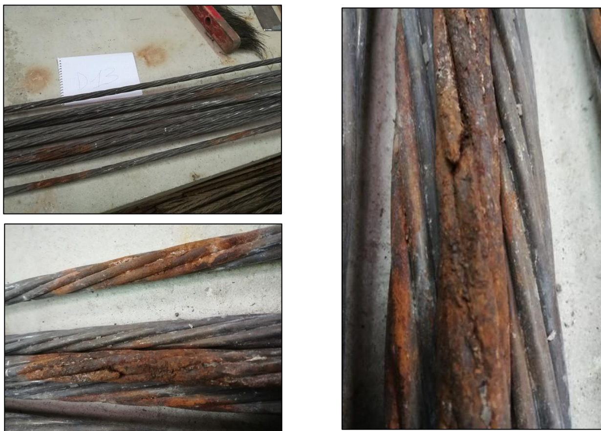
Figure n°25 : Zones de corrosion avec rupture d'un fil
