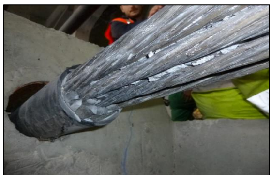
Figure n°27 : Bonne injection et torons sains
