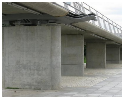
Piles de ponts
