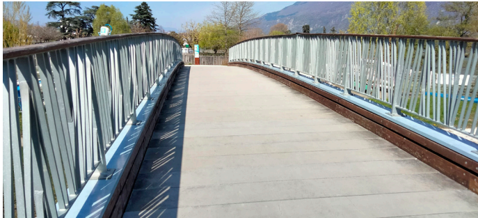
Structure métallique implantée sur Le-Bourget-du-Lac/Viviers-du-Lac
