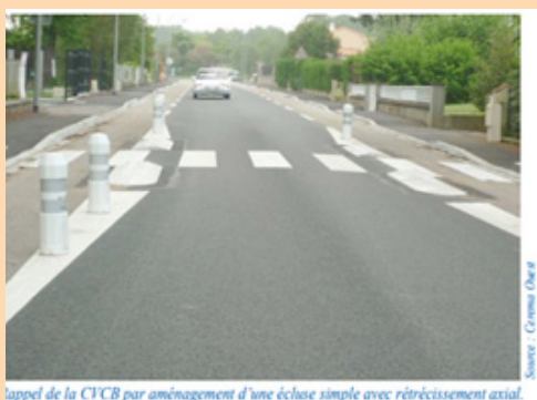
appel de la CVCB par aménagement d'une écluse simple avec rétrécissement axial.
