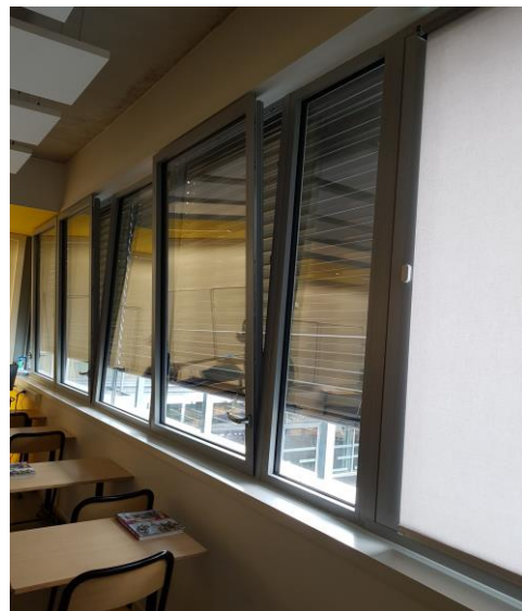
Figure 2 : Fenêtre en position oscillo-battante Source : Cerema
