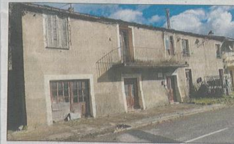
La commune de Pie-d'Orezza a acquis ce bâtiment pour le rénover et y installer la mairie, un logement et un cabinet médical. DOCUMENT CORSE-MATIN
