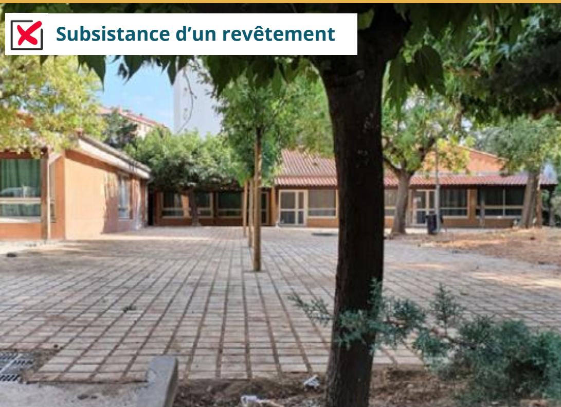
Désimperméabilisation d'une cour d'école
