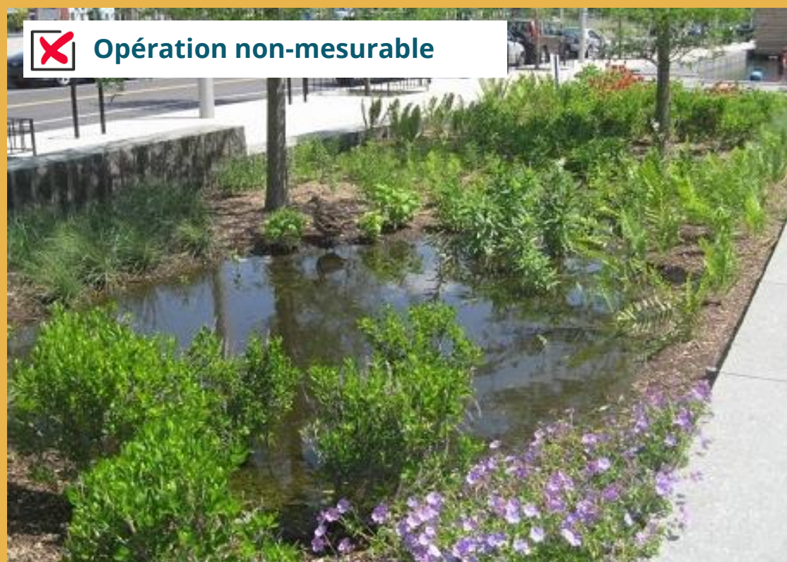
Aménagement d'un jardin de pluie
