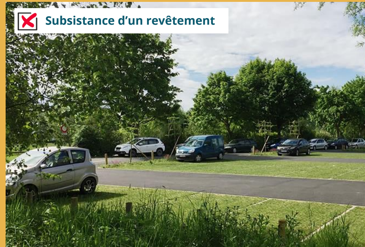
Désimperméabilisation d'un parking
