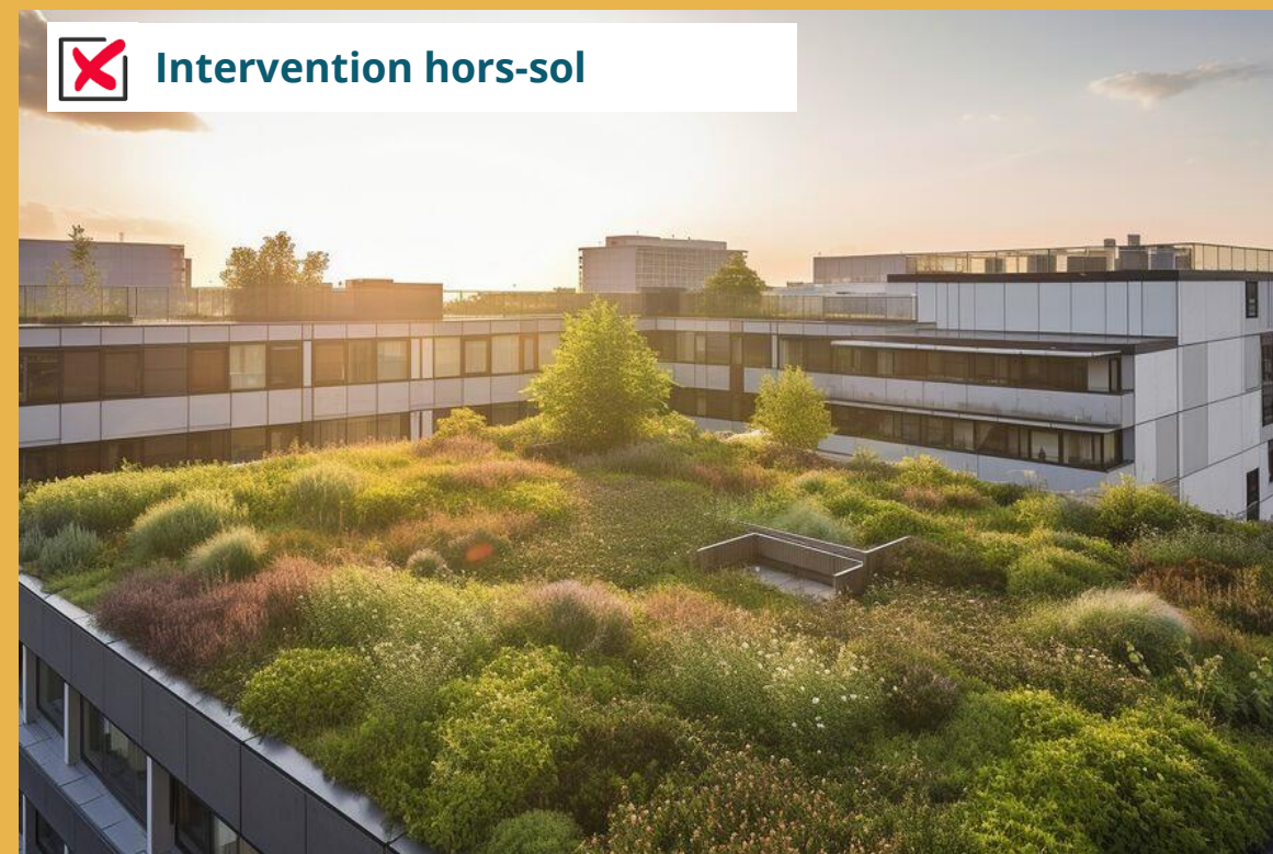
Végétalisation d'une toiture
