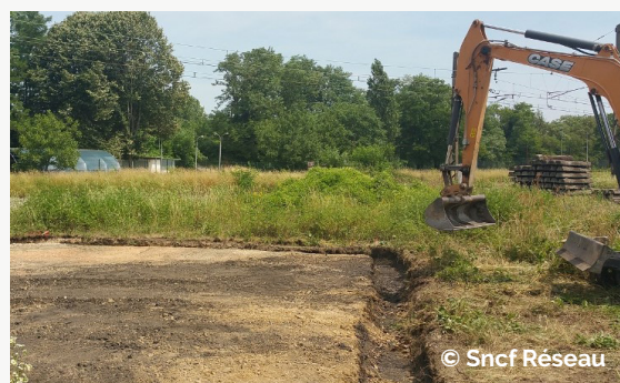
Creusement d'une tranchée en périphérie de la zone à bâcher.
