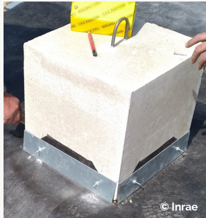
Fixation verticale de la bâche à un massif caténaire avec colle polyuréthane et réglette inox.
