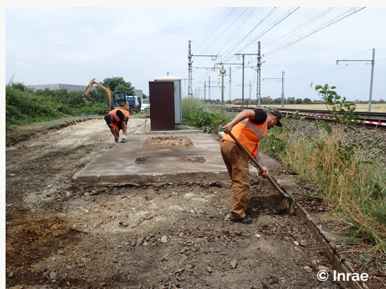
Nettoyage de la zone à bâcher.
