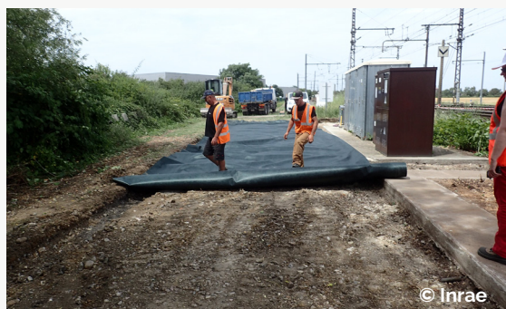
Pose d'un géotextile synthétique anti-renouée.
