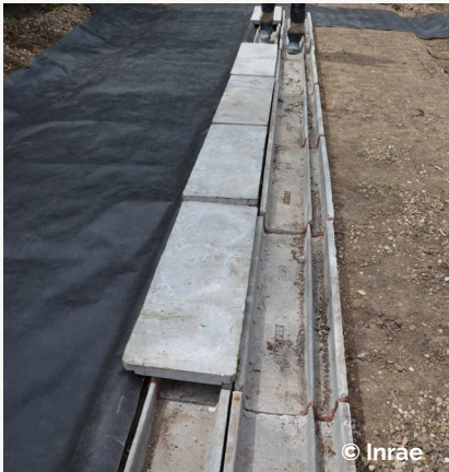
Fixation d'une bâche dans un caniveau par recouvrement de couvercle.
