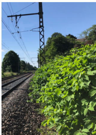
Massif de renouée en bord de voie limitant le passage des agents
