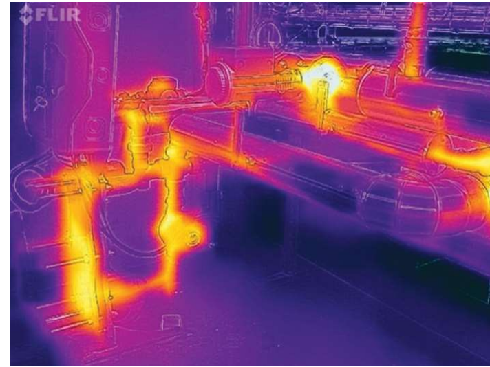
Déperditions thermiques du réseau de chauffage (Dinan)
