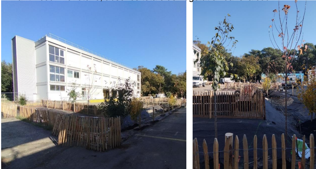
Après : nouvelle cour aux usages redéfinis (plantations en cours)
