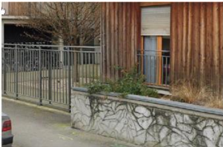
Rue de Verdun, Amiens Traitement architectural du socle
