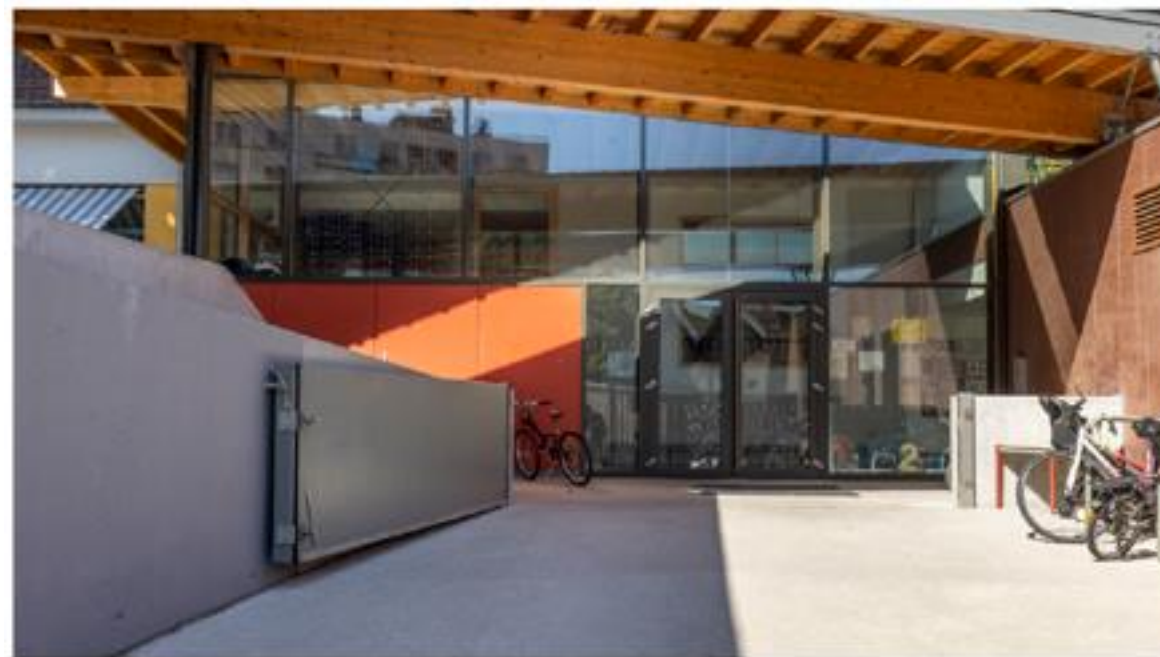
École Diderot, Grenoble Porte étanche. La rampe permet d'en diminuer la hauteur
