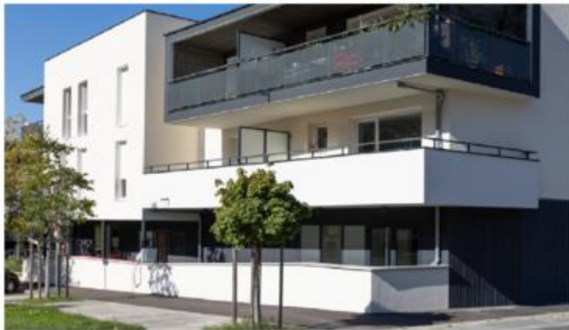
Mur déflecteur intégré au bâti
