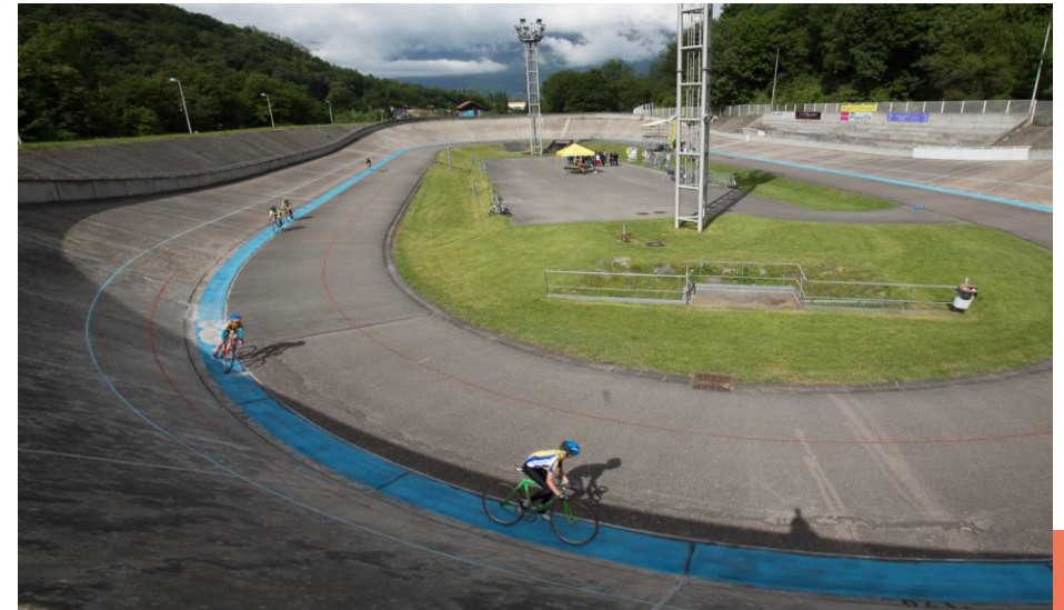
Bassin de rétention du Verderet, Eybens
