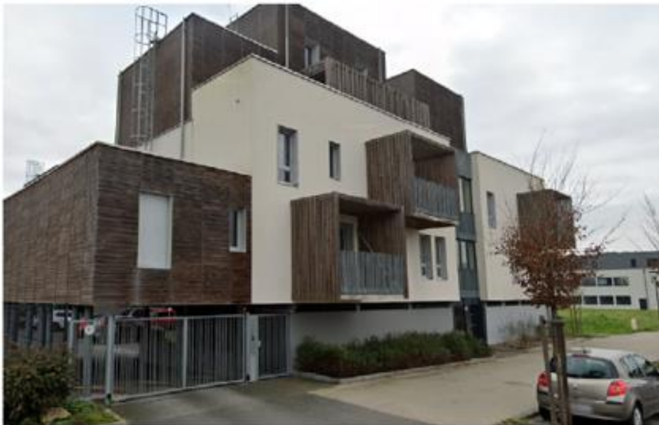
Garage et céliers au rdc de l'immeuble Pré Pinguet - Saumur Atome architecture + DcB architectes - Saumur Habitat
