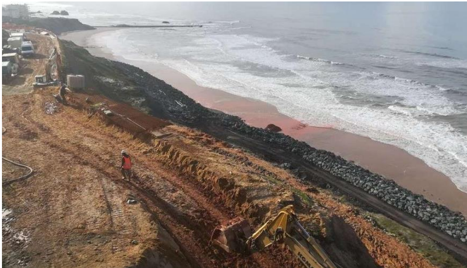
Travaux au sud de la côte des basques
