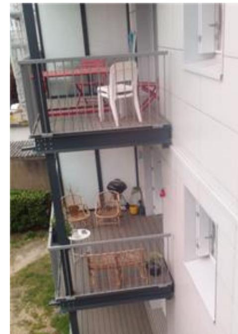
Val de Loire : traitement des ponts thermiques : remplacement des balcons par des terrasses autoportées
