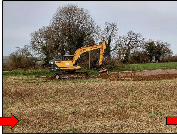
2-Mise en forme du talus
