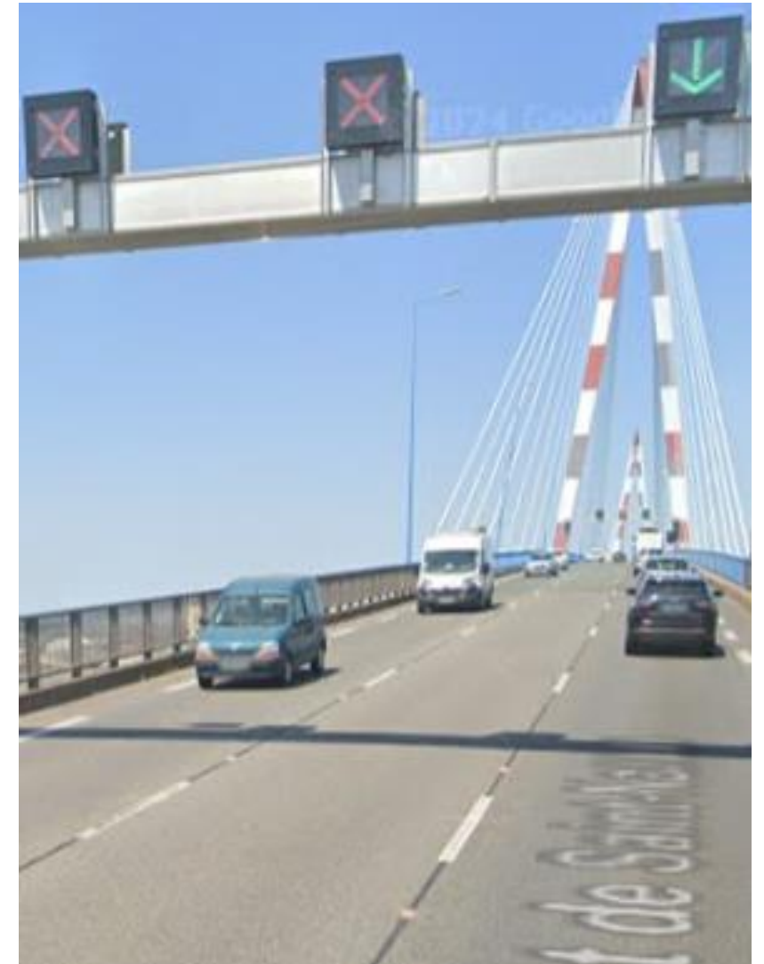
Signalisation horizontale dynamique – Modification de la réglementation
