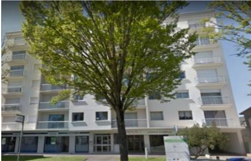
Figure 9: Le Strogoff après rénovation - Architecte: CHANTIERS INGENIERIE
