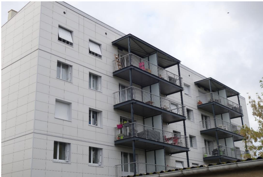
Figure 10 : Résidence Val de Loire après rénovation - Architecte: Frédéric MAURET, Architecte du Patrimoine
