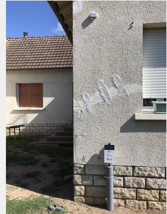
Maison test MACH+ (41) Crédit photo : L. Ighil Ameur © Cerema 2022
