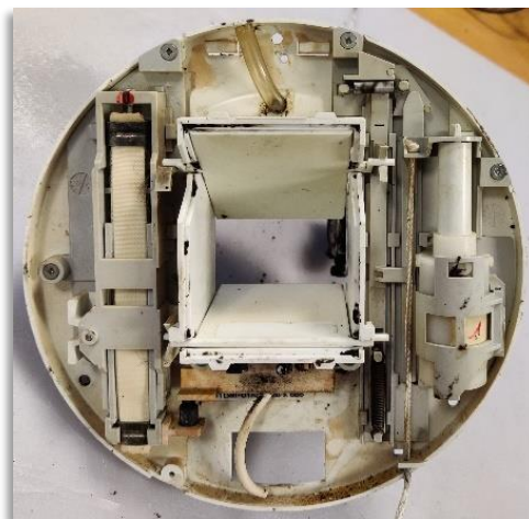
Terminaux de ventilation après nettoyage
