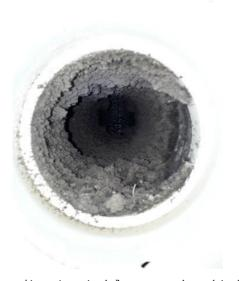
Figure 15 : Photographie représentative de l'encrassement des conduits de ventilation
