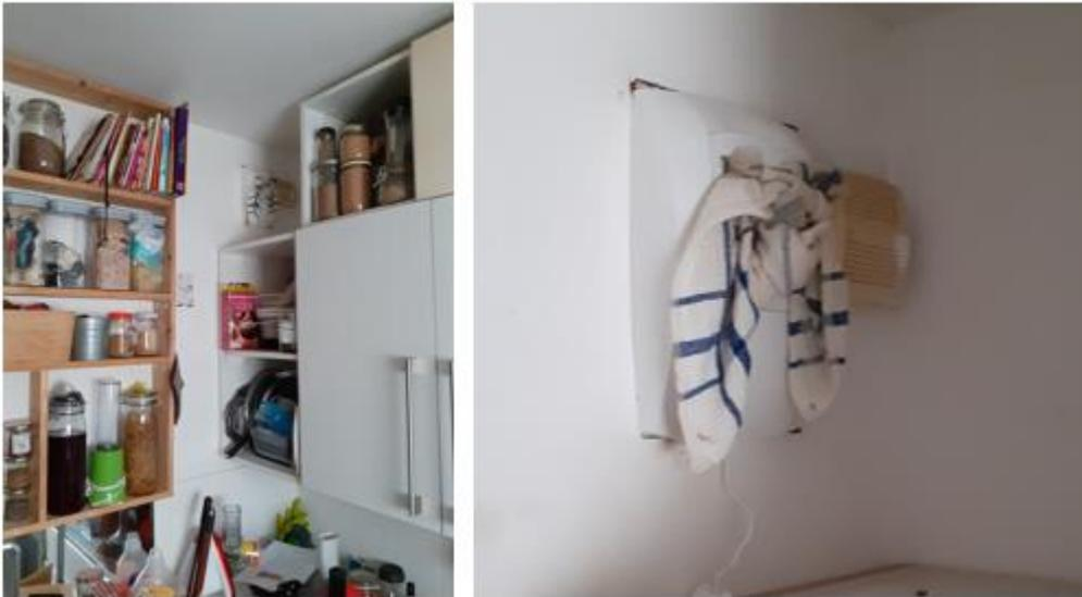
Figure 3 : Exemples d'obstruction des bouches d'extraction identifiés dans des logements de Performance 2
