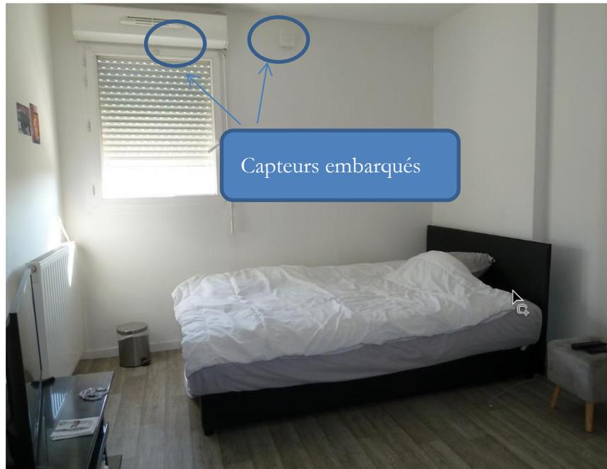
Figure 6 : Photo chambre avec positionnement entrée d'air et capteur embarqués– logement V4
