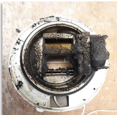
Figure 4 : Bouche d'extraction cuisine vue de l'intérieur avant (a) et après nettoyage (b). Bouche d'extraction cuisine en vue arrière avant (c) et après nettoyage (d)
