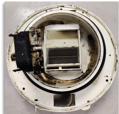
Figure 4 : Bouche d'extraction cuisine vue de l'intérieur avant (a) et après nettoyage (b). Bouche d'extraction cuisine en vue arrière avant (c) et après nettoyage (d)
