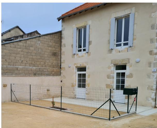
Rénovation énergétique des logements à Champagné-Saint-Hilaire
