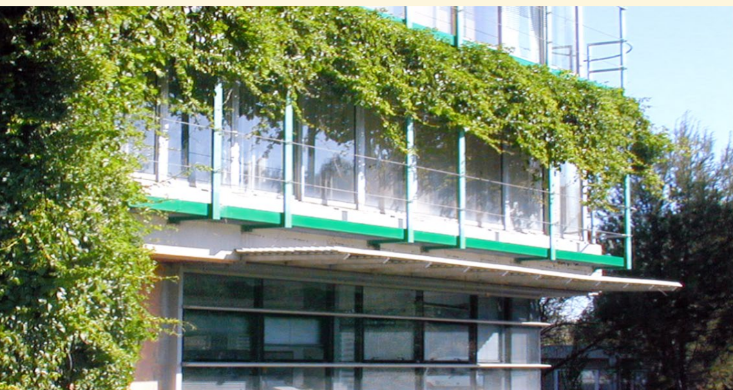
Protection solaire devant la façade vitrée d'un bâtiment
