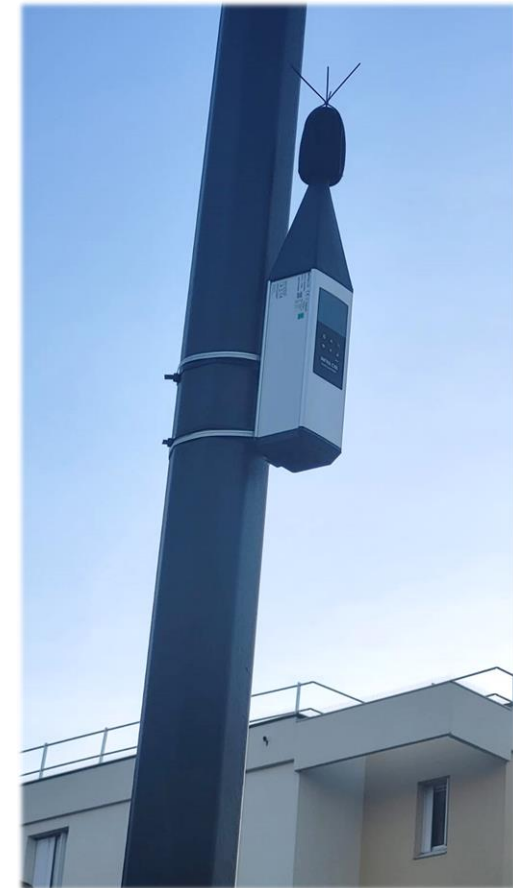
Sonomètre C50 installé sur site
