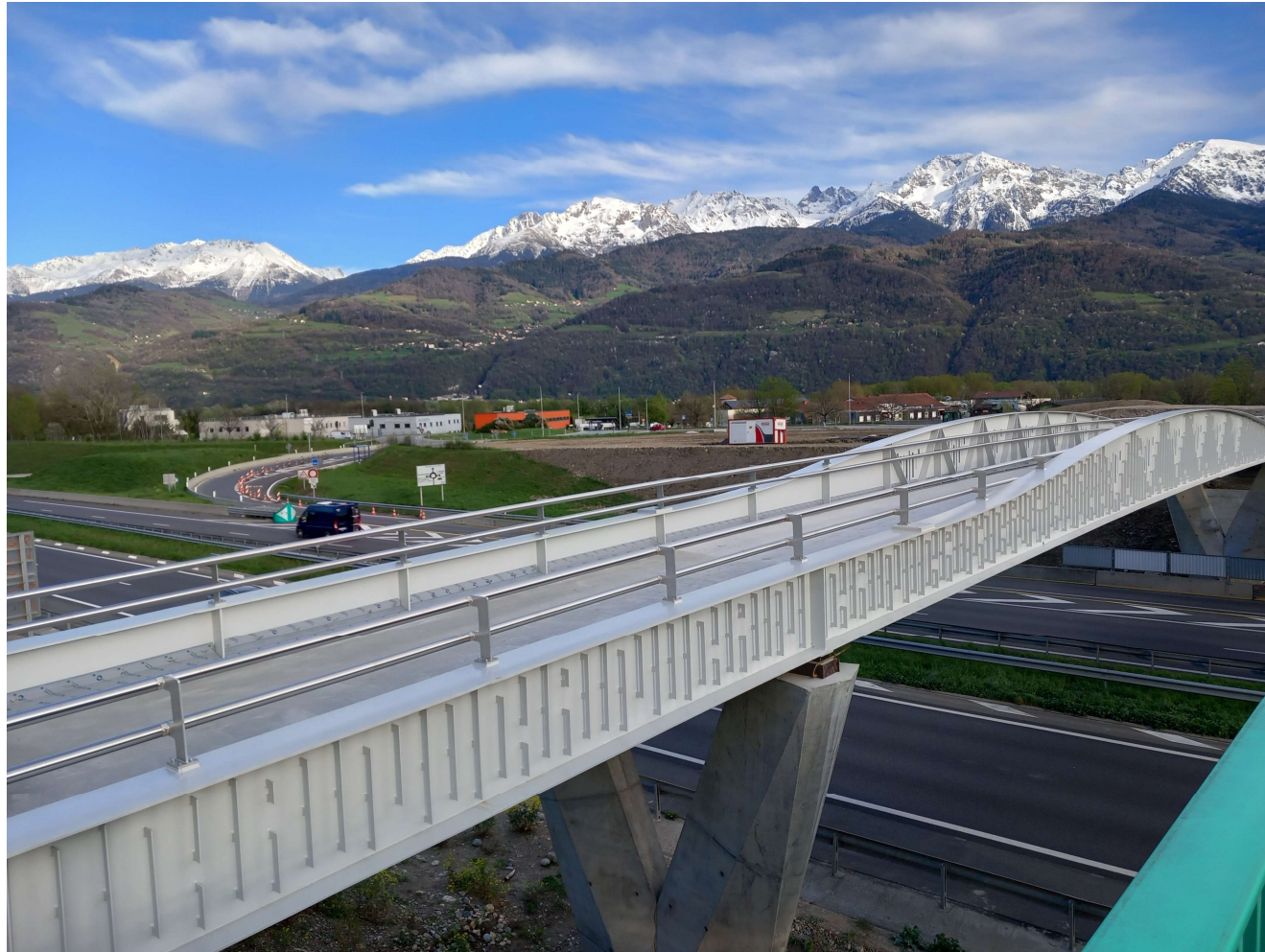
Passerelle PEM La Bâtie - Mars 2023
