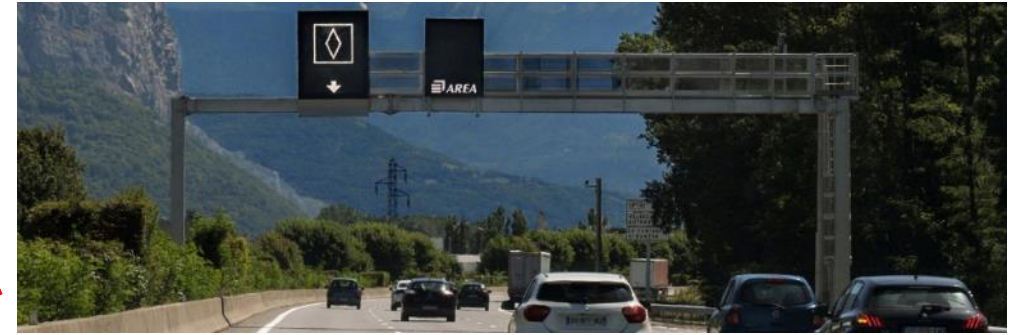
Barrière de péage de Voreppe
