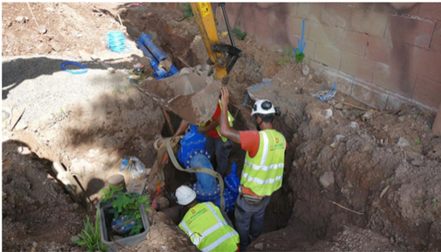
Installation de nouvelles canalisations d'eau potable. Crédit photo : L. Dautreppe / OFB
