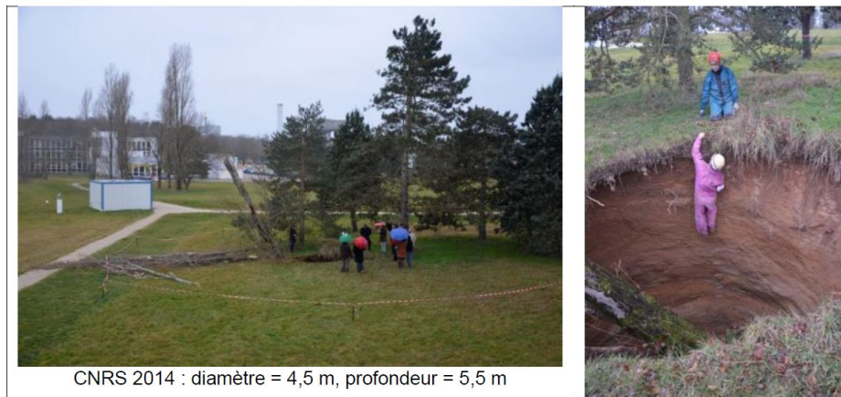
2014 - Effondrement au CNRS : diamètre = 4,5 m, profondeur = 5,5 m.
