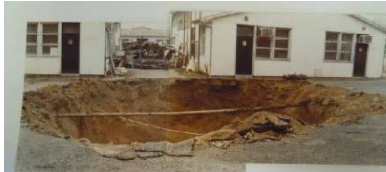
1986 - Effondrement à l'Université : diamètre \approx 10 m, profondeur \approx 3-4 m.
