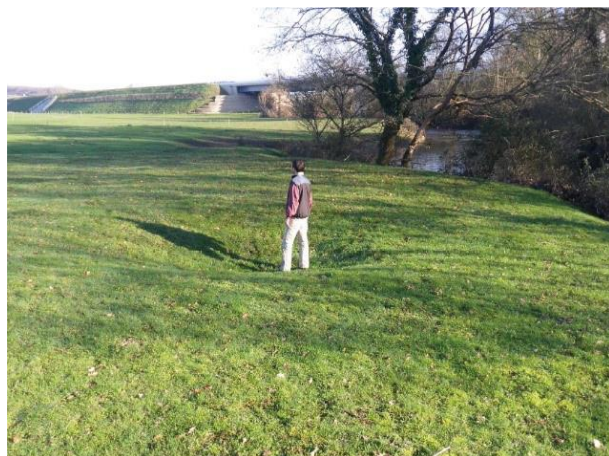
Affaissement sur les rives de la Tardoire (16) Cerema
