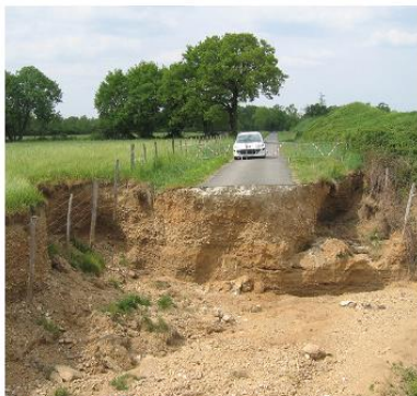
Route emportée (16) - Cerema
