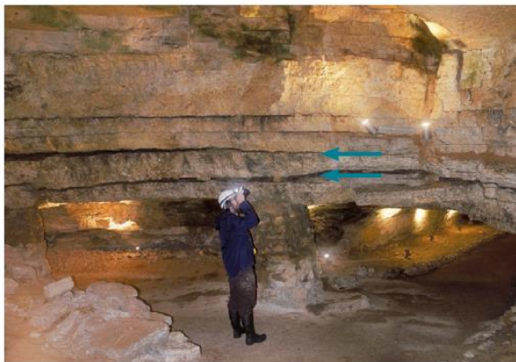
Décollement des bancs à Bèze (21) – BRGM
