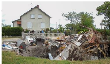
Maison détruite (45) - DDT45
