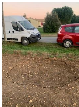
Affaissement soudain (24) Cerema
