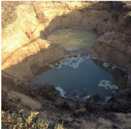
Effondrement à Sandillon (45) - BRGM
