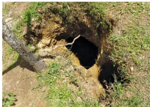
Effondrement lié au déboufrage de cheminées à Saint-Maixant (33) - Cerema
