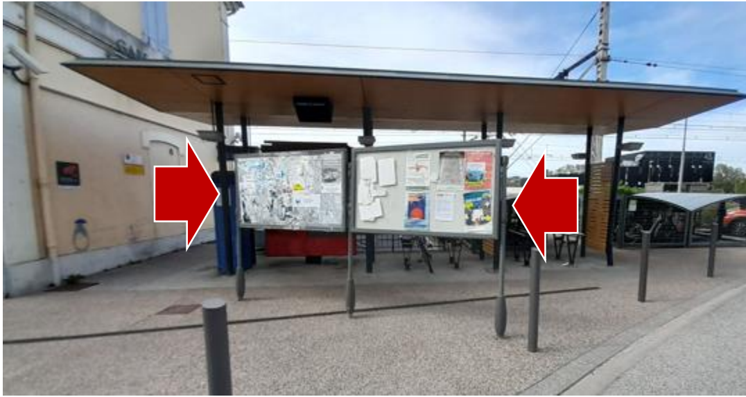
Dans cette gare périurbaine très fréquentée, deux panneaux d'informations municipales ont été implantés juste devant les automates et les arceaux à vélo
