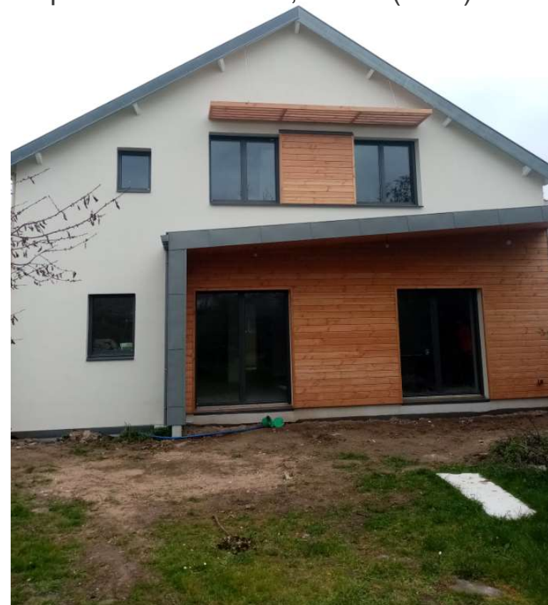
Rénovation: Architecte Solecité
