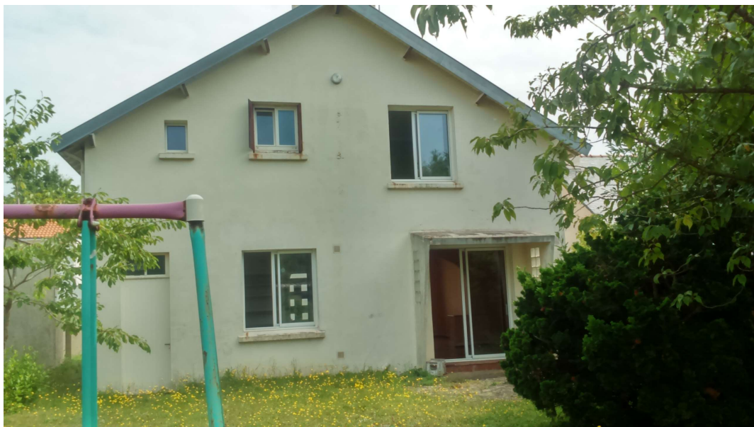
Bâtiment avant rénovation : isolation sous rampant de 30 à 18 cm Laine de verre, pas d'isolation des murs, double-vitrage aluminium
