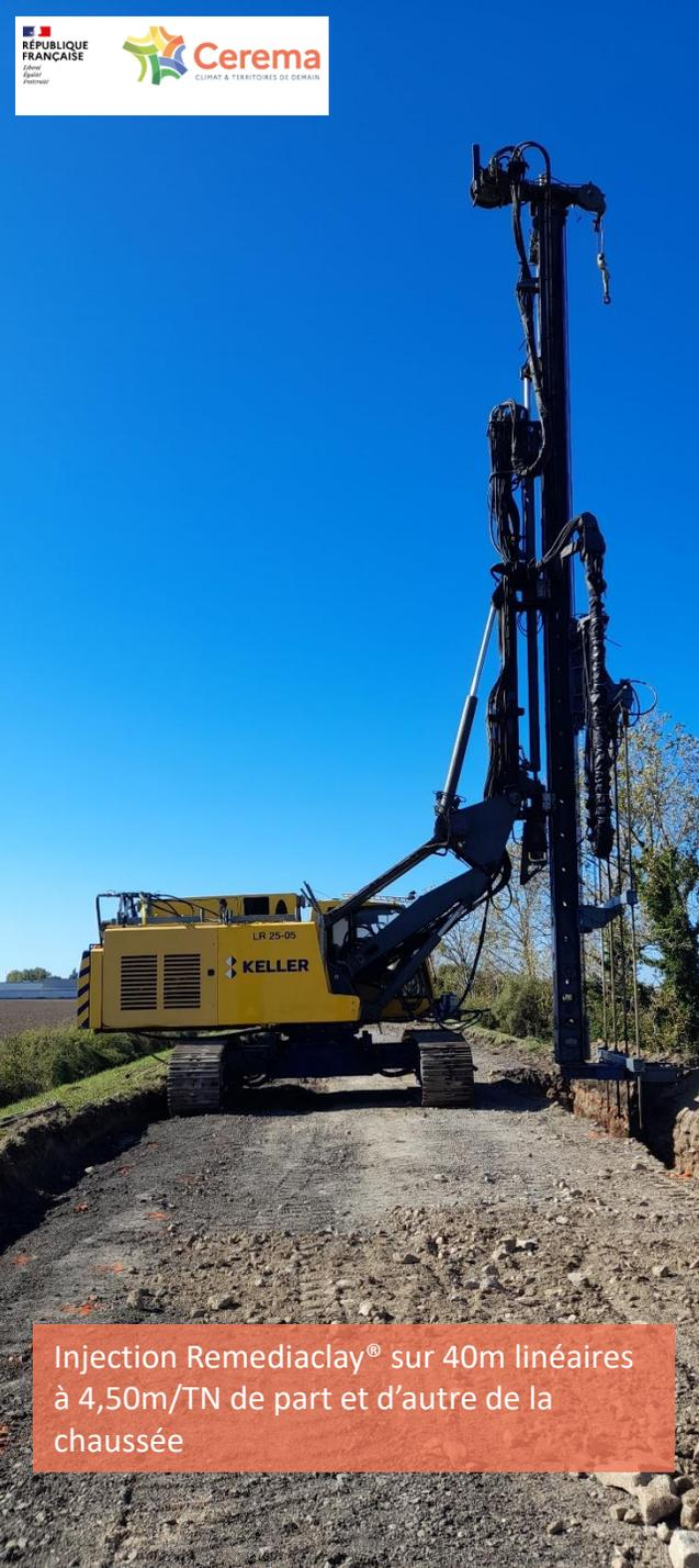
Injection Remediaclay® sur 40m linéaires à 4,50m/TN de part et d'autre de la chaussée
