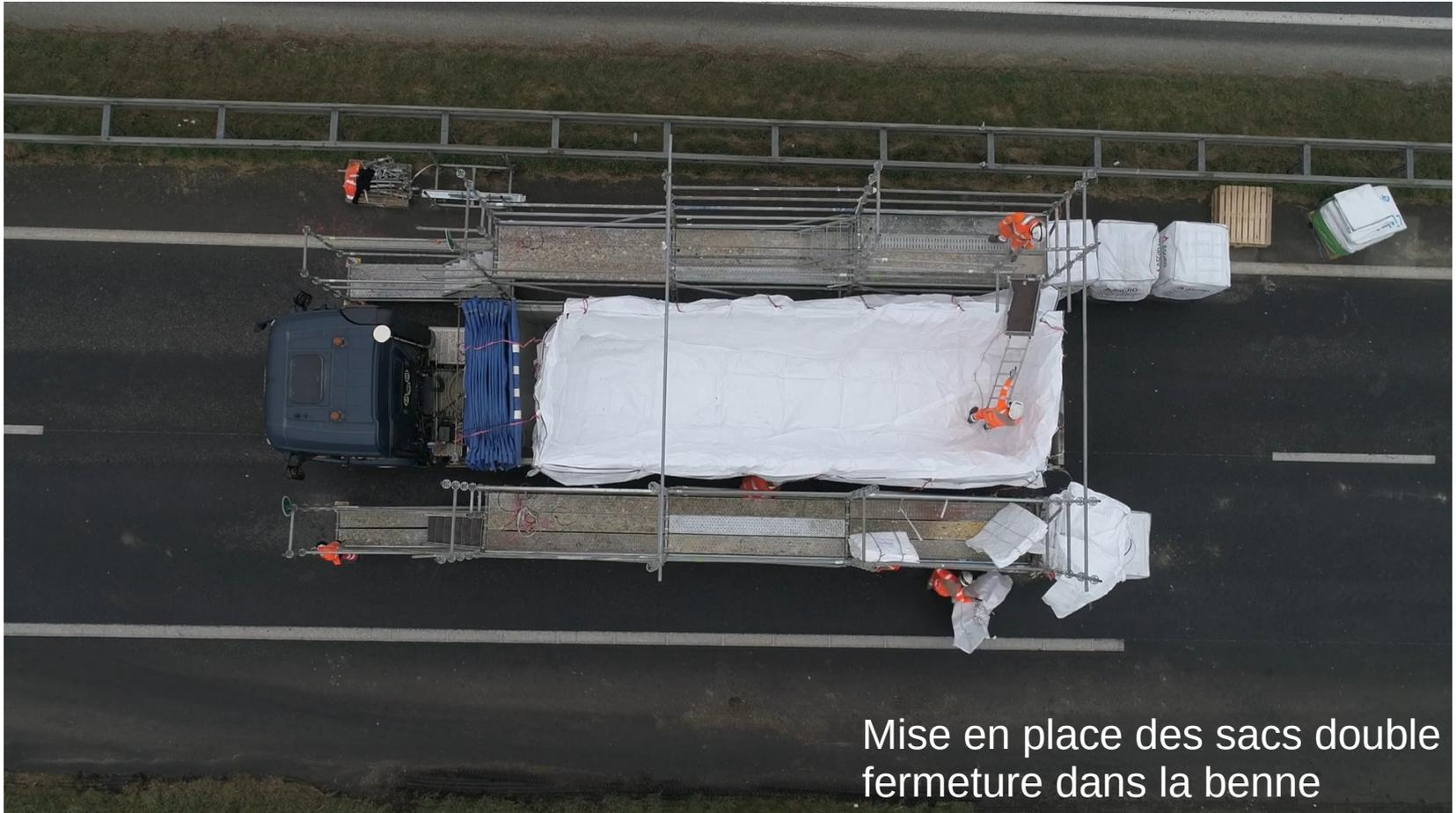
Mise en place des sacs double fermeture dans la benne
