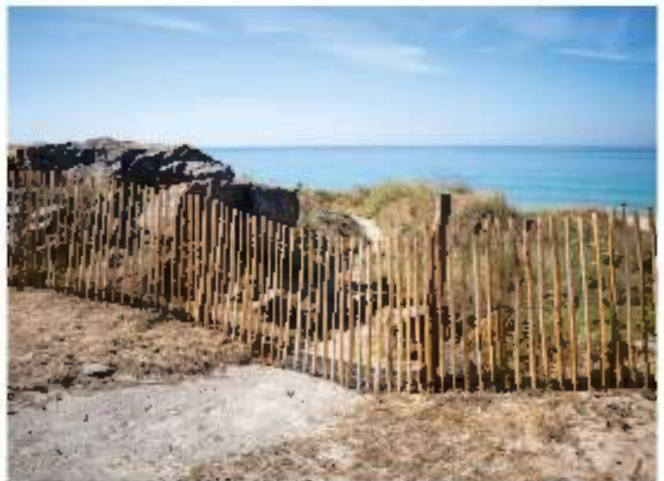
Figure 137 : rideau de ganivelles sur la plage de Mesperleuc à Plouhinec.
