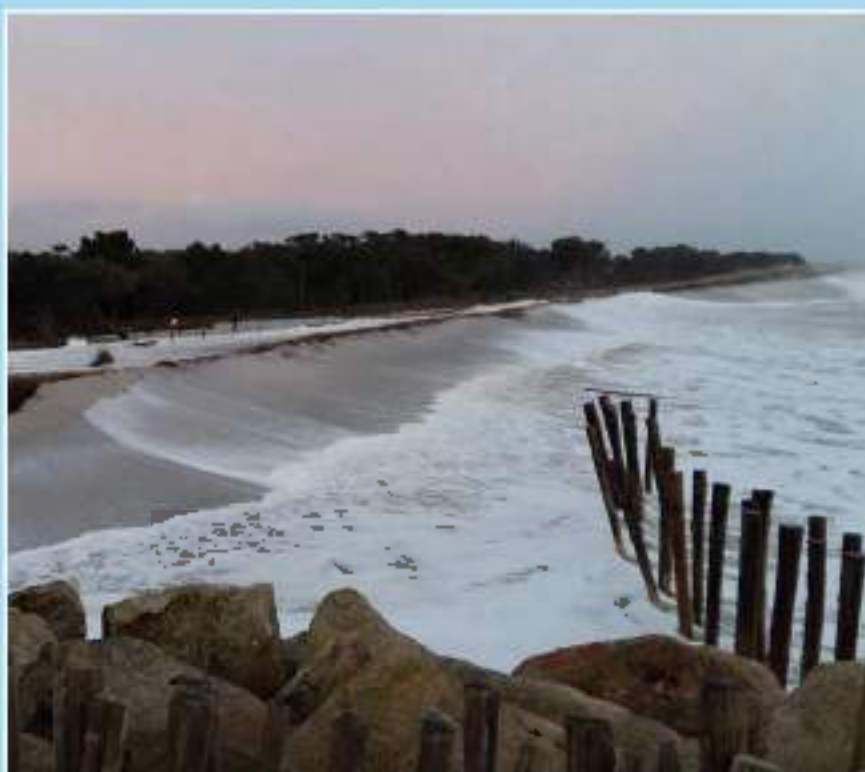
Figure 28 : vagues franchissant le sommet de la dune de la plage de Cleut-Rouz et submergeant le secteur arrière-dunaire.
