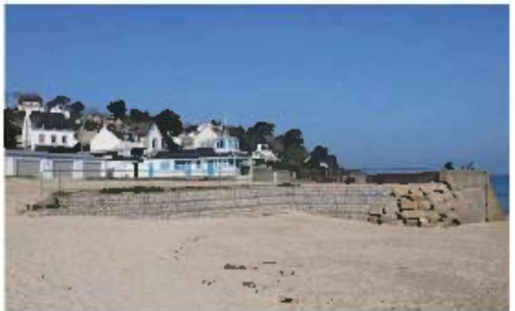
Figure 78 : gabions de soutènement sur la plage des Sables-Blancs à Douarnenez.
