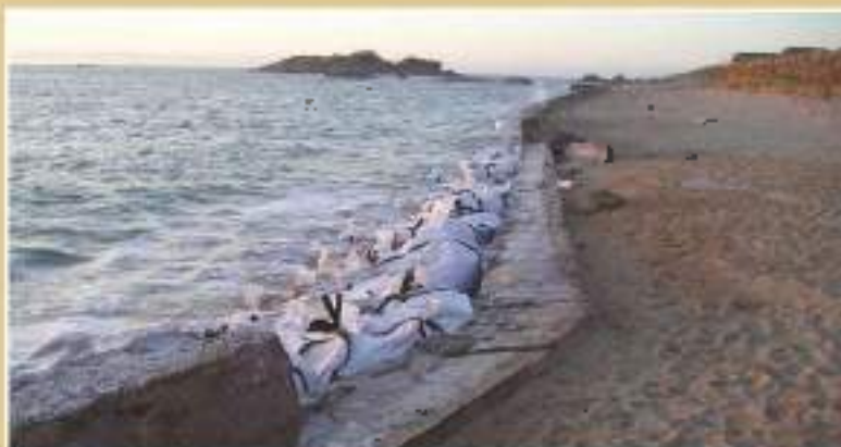
Figure 38 : le muret protégé par des big bags durant l'été 2008.
