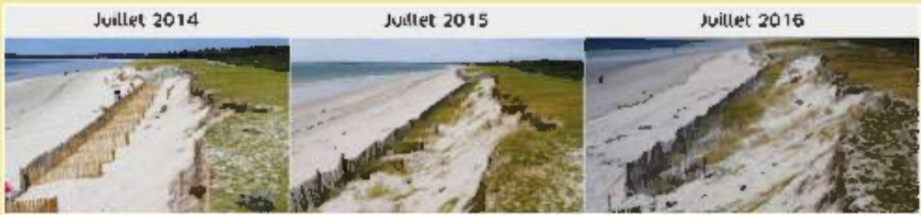
Figure 170 : évolution du front dunaire sur la plage de Penvins à Sarzeau (56) après l'installation du dispositif entre 2014 et 2016. Le site est désormais stabilisé et la commune de Sarzeau procède à des remplissages d'algues tous les 1 ou 2 ans pour renforcer l'ensablement du pied de dune.
