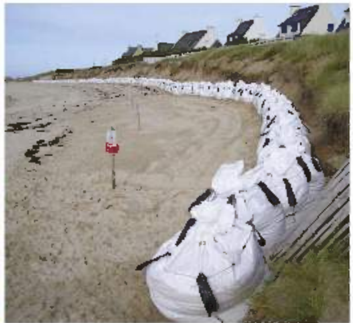
Figure 18 : ouvrages longitudinaux : en haut, en enrochements, plage de Trescaderc, Audierne ; en bas : en big bags, plage de la Grève Rose, Trégastel.
