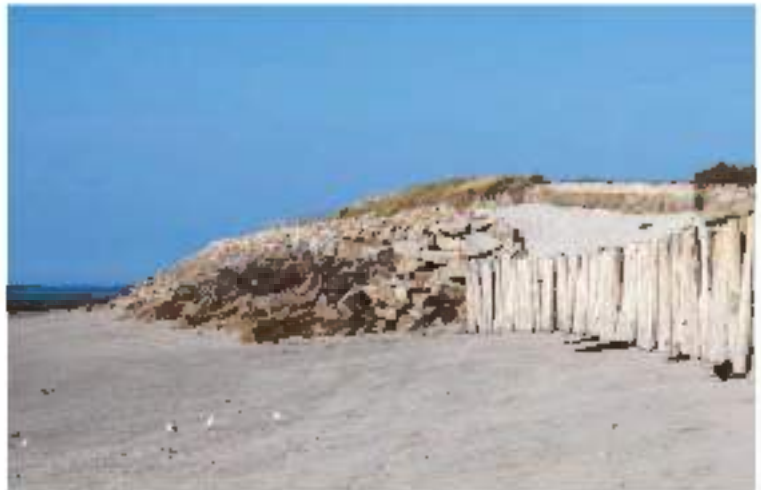
Figure 19 : perré en enrochements sur la plage de Léhan à Treffiagat.
