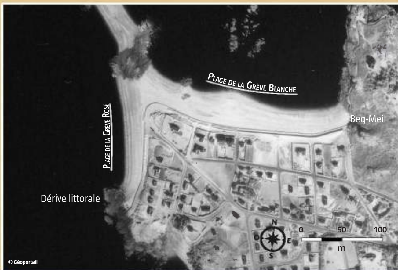
Figure 37 : vue aérienne (infra-rouge) de 1978 (IGN) des plages de la Grève-Rose et de la Grève-Blanche montrant le positionnement du muret de protection sur le haut des plages et vue au sol de l'état du muret après la tempête Johanna de mars 2008.
