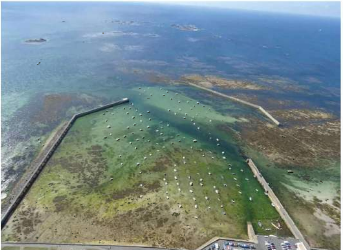
Figure 64 : brise-lames de protection portuaire à Penmarc'h.
