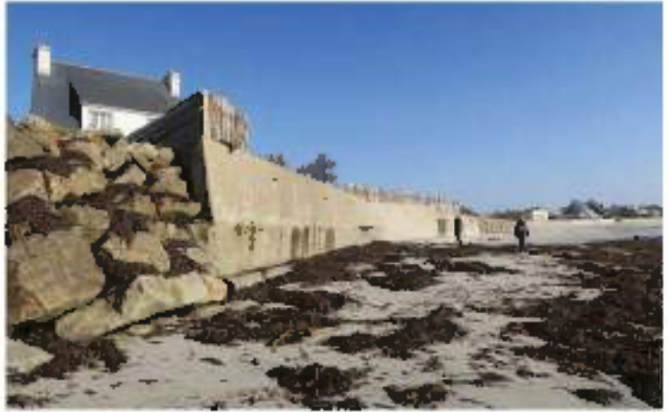
Figure 76 : mur en béton, plage de Poulluen à Loctudy.
