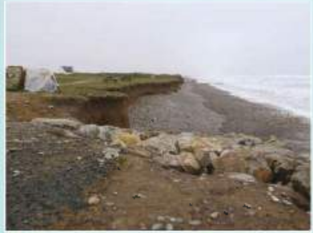
Figure 34 : surcreusement de la falaise de Ruvein, au nord de l'enrochement.
