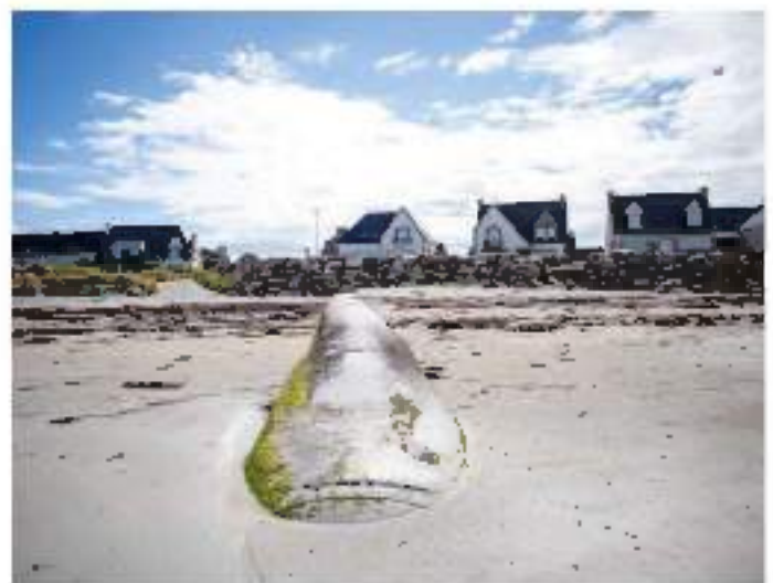
Figure 46 : épi en boudin géotextile sur la plage de la Grève-Blanche au Guilvinec.
