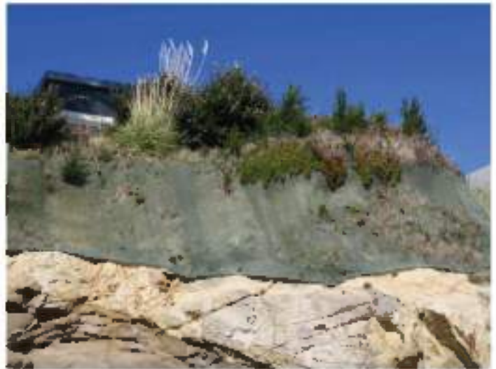
Figure 84 : à gauche : sécurisation en béton projeté sur la falaise de la plage du Liouquet à La Ciotat (13) (d'après BRGM, 2014) ; à droite : protection en filets grillagé contre la chute de blocs en sommet de falaise de granite très altéré à Plougonvelin (2022).
