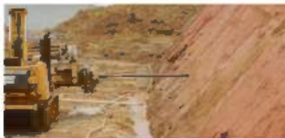
Figure 94 : forage de drains subhorizontaux dans une falaise.
