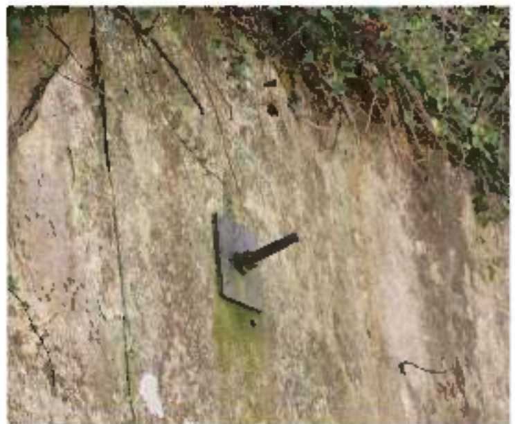
Figure 85 : ancrage dans un mur à Douarnenez.
