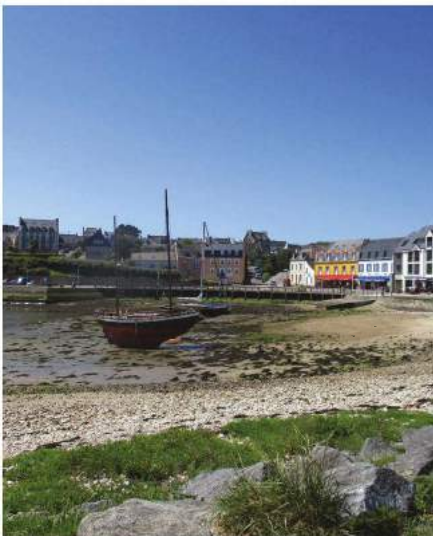
Figure 1 : ouvrages portuaires protégeant le littoral urbanisé de Camaret-sur-Mer.
