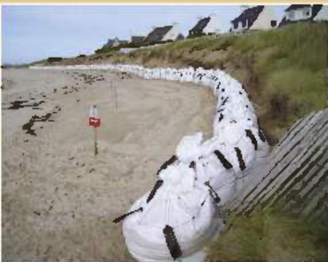
Figure 40 : utilisation des big bags en pied de dune. A gauche, après leur installation durant l'été 2010. A droite : état après l'hiver 2013-2014.
