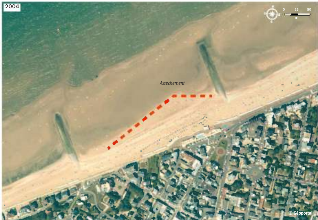
Figure 134 : plage de Villers-sur-Mer (14), un an après l'implantation du procédé de drainage.
