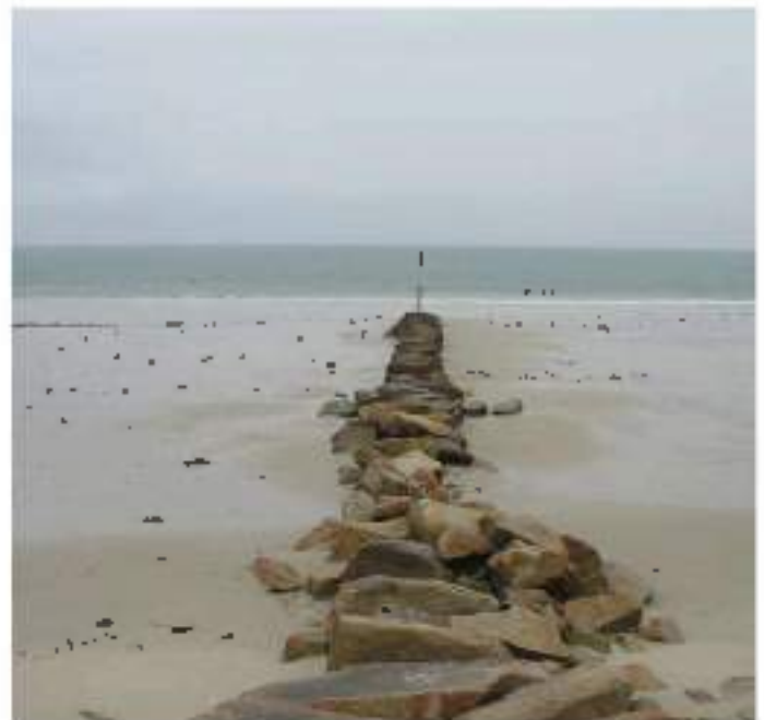
Figure 45 : épi en enrochements sur la plage du Téven à l'Île-Tudy.
