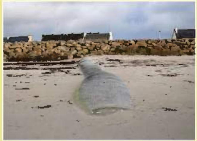
Figure 55 : accumulation de sable à l'amont-dérive de deux des trois épis installés sur la plage de la Grève-Blanche, novembre 2021. A gauche : épi n° 1 ; à droite : épi n°2 (cf. localisation des deux épis sur la figure 53).
