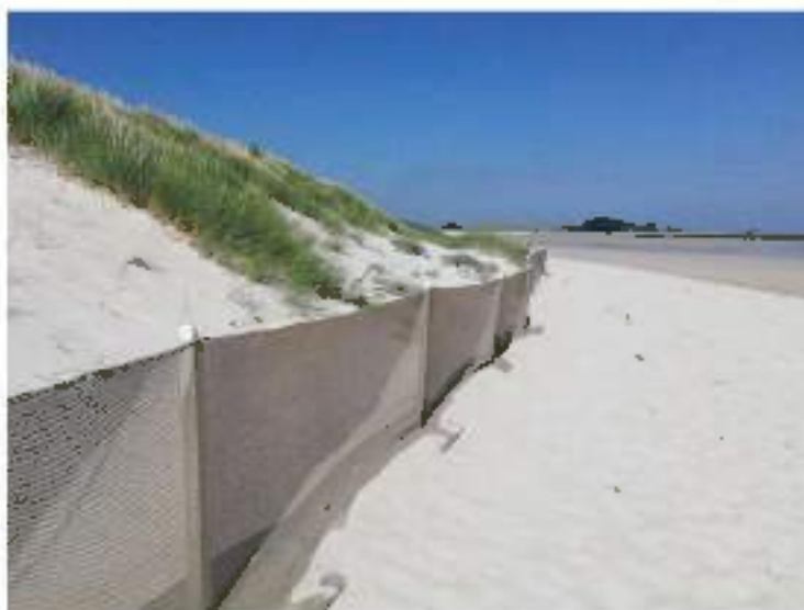
Figure 151 : filet brise-vent en pied de dune de la plage des Trois Moutons à Lampaul-Ploudalmézeau.
