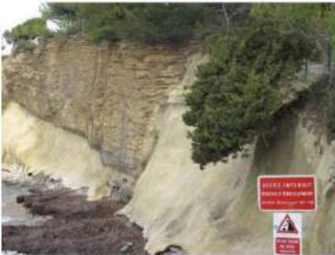
Figure 84 : à gauche : sécurisation en béton projeté sur la falaise de la plage du Liouquet à La Ciotat (13) (d'après BRGM, 2014) ; à droite : protection en filets grillagé contre la chute de blocs en sommet de falaise de granite très altéré à Plougonvelin (2022).
