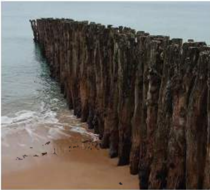
Figure 44 : deux types de matériaux mis en œuvre dans la construction d'épis. A gauche : en pieux de bois à Saint-Malo ; à droite : en enrochements sur la plage du Moulin Blanc à Brest.
