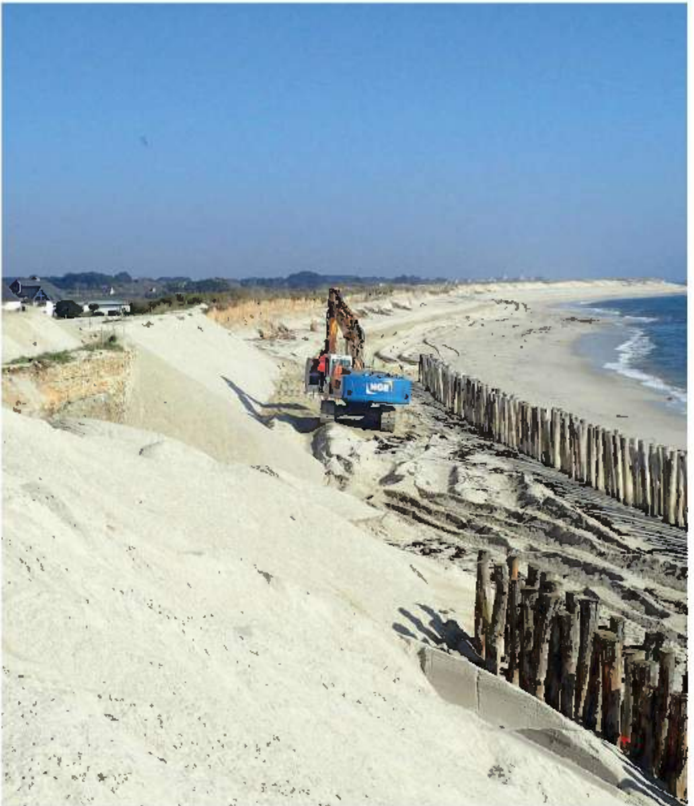
Figure 124 : systèmes de pieux hydrauliques implantés en quinconce selon deux alignements parallèles au trait de côte, à Treffiogat, en avant de la dune en cours de confortement. Les dispositifs de pieux sont positionnés dans le secteur en érosion accélérée, à l'extrémité d'enrochements. La dénivellation visible de part et d'autre de la rangée de pieux la plus basse sur la plage montre qu'une accumulation de sable s'est bien produite en arrière d'eux sur le haut de plage. Pour autant, le trait de côte est toujours en érosion rapide.
