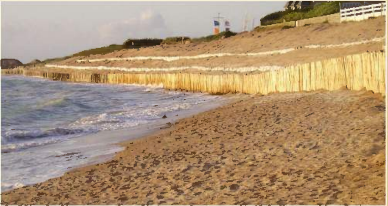
Figure 39 : état de la plage et de la dune après les travaux de reconstitution du cordon réalisés dans le cadre du contrat Natura 2000 : reprofilage du versant au vent de la dune, pose de filets brise-vent en géotextile et rideau de ganivelles (atteints par les niveaux de haute mer) en pied de dune.
