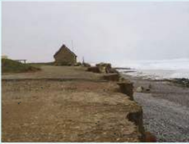
Figure 34 : surcreusement de la falaise de Ruvein, au nord de l'enrochement.
