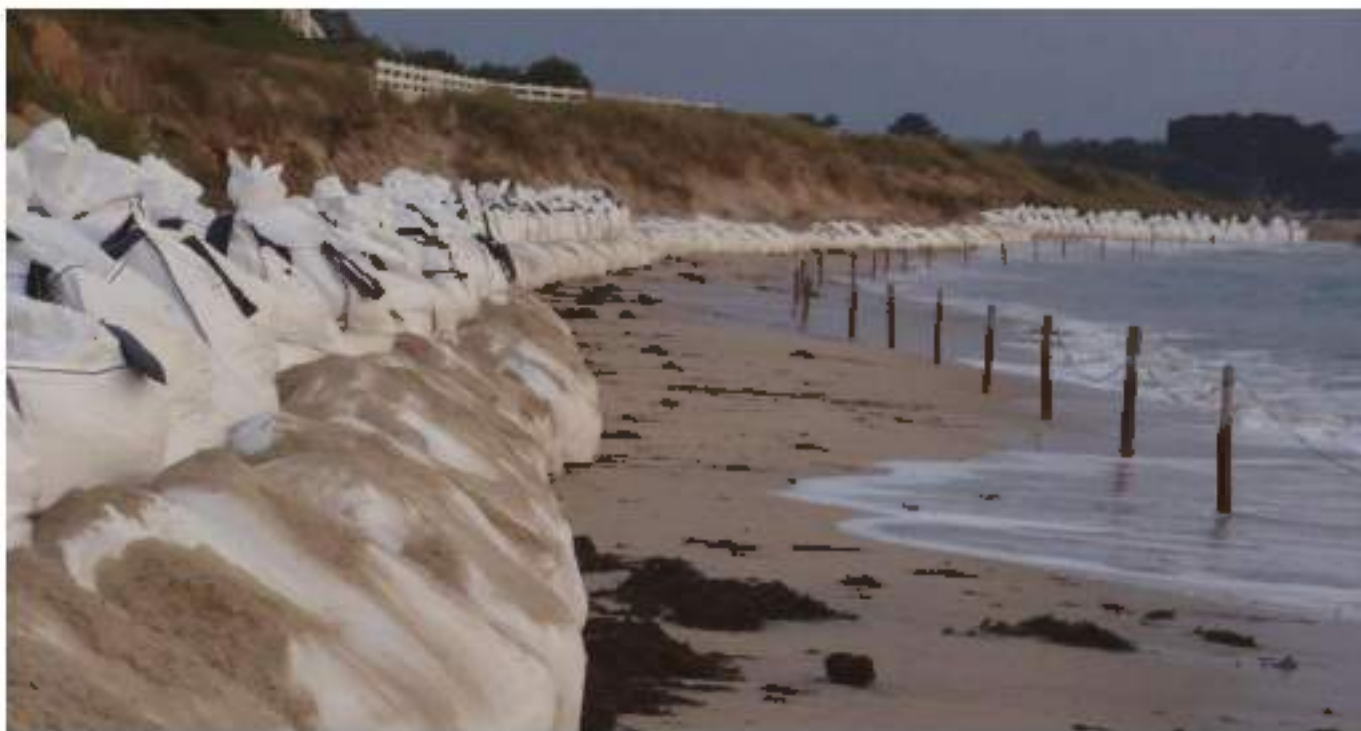
Figure 22 : protection en big bags sur la plage de la Grève-Rose à Trégastel.
