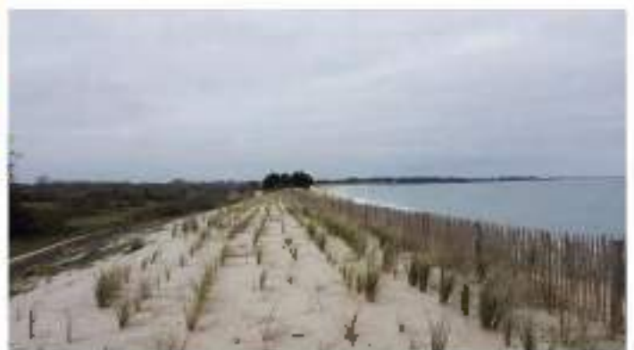
Figure 149 : à gauche, un filet brise vent en pied de dune sur la plage de Squididan à Treffiagat ; à droite, des plantations d'oyats et des rideaux de ganivelles après un confortement dunaire à Combrit.
