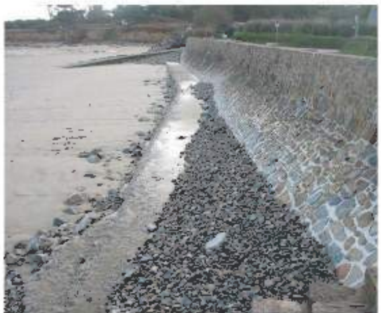
Figure 75 : mur maçonné, Plougrescant (Côtes-d'Armor).
