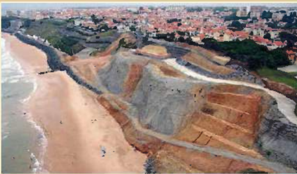
Figure 101 : reprofilage d'une partie de la falaise de la côte des Basques à Biarritz (64). (d'après Antea, 2006)
