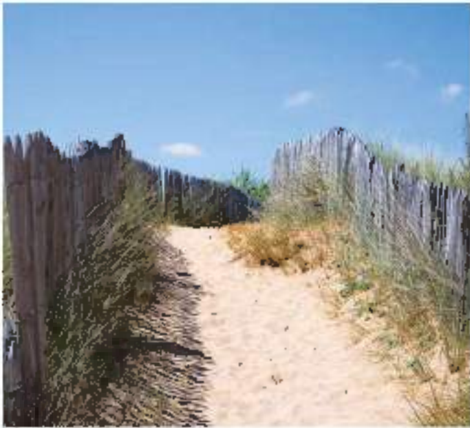
Figure 136 : dispositifs de canalisation de la fréquentation dans les dunes. A gauche : accès à la plage canalisé par des ganivelles sur la plage du Bellangenet à Clohars-Carnoët ; à droite : des cheminements encadrés par des clôtures filaires basses à Meneham à Kerlouan.
