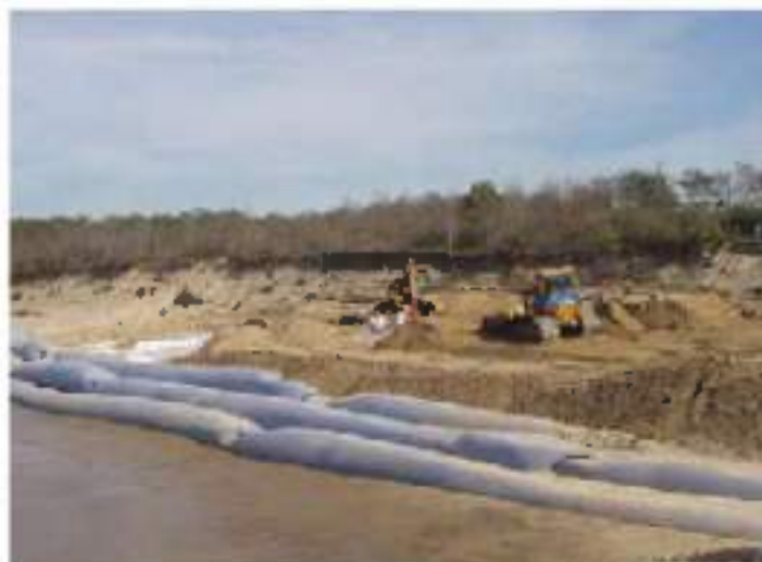
Figure 67 : protection de la plage de l'Amélie à Soulac (33) par tubes brise-lames.
