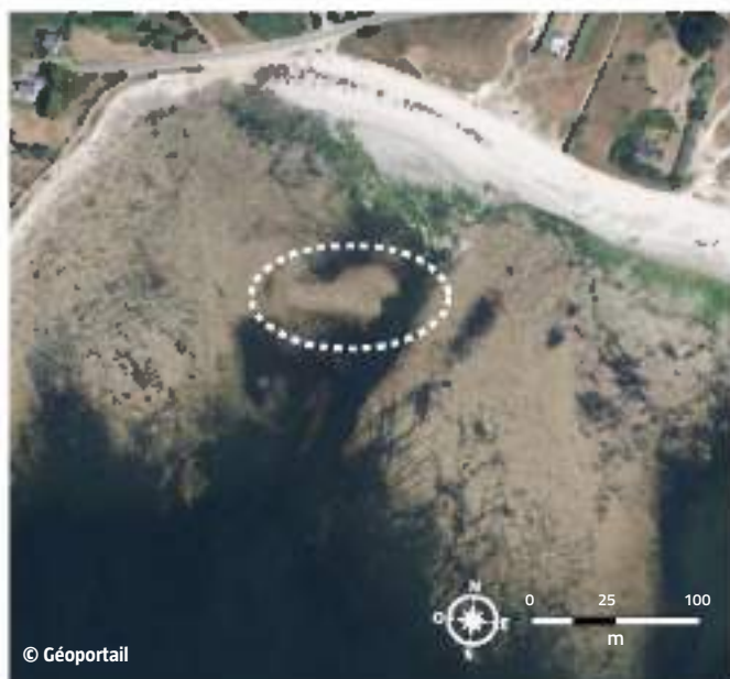
Figure 66 : brise-lame en blocs d'enrochement au large de la plage de Kersiny à Plouhinec.
