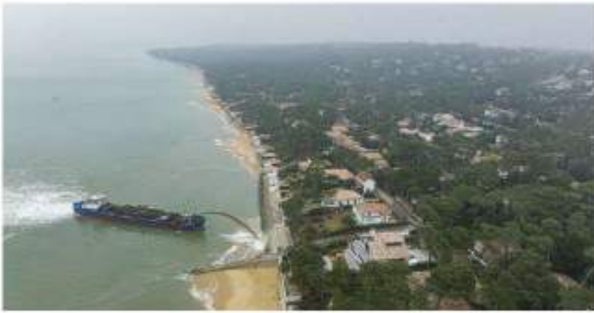
Figure 112 : opération de rechargement de plage : refoulement des sédiments prélevés en mer par la drague et régamage sur la plage par pelles mécaniques.
