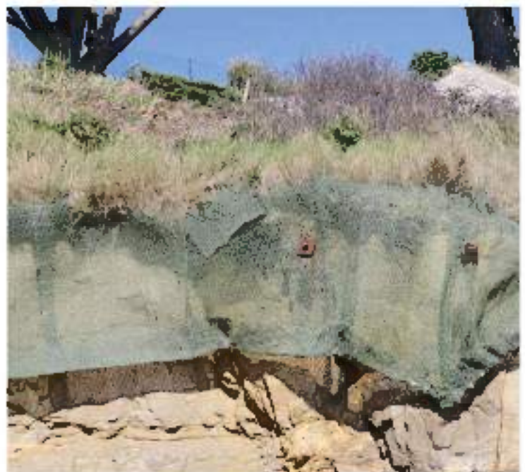
Figure 86 : géogrille renforcée en sommet de falaise à Plougonvelin.
