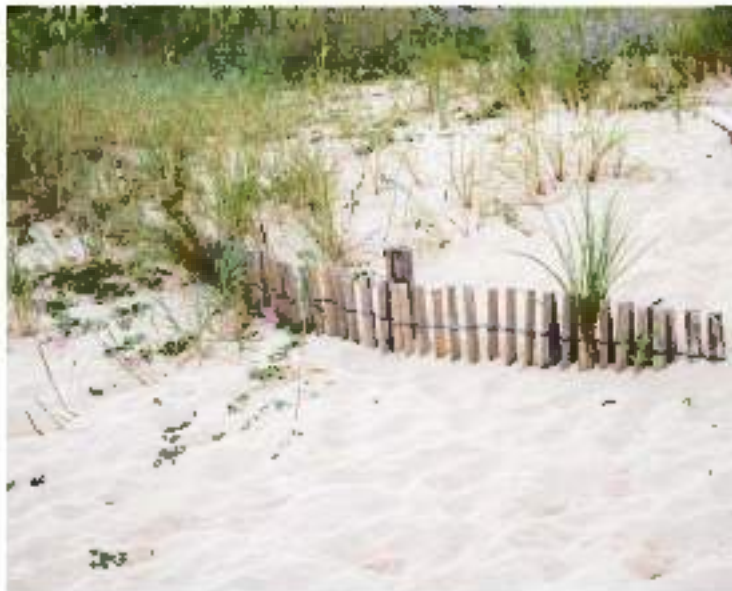
Figure 150 : rideau de ganivelles presque totalement enseveli sur la plage de Trescaderc à Audierne.
