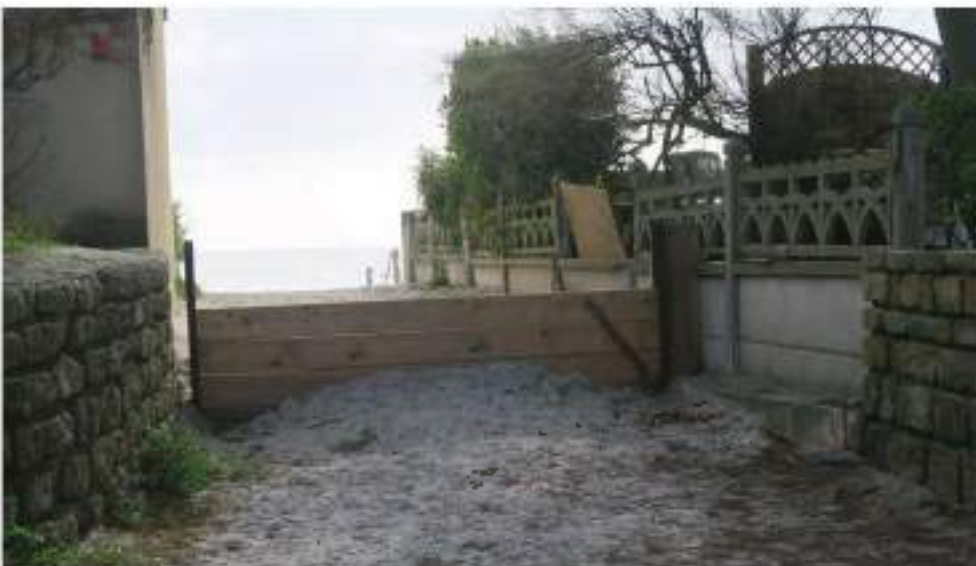
Figure 156 : barrières anti-submersion devant un accès à la plage entre deux propriétés privées | Loctudy.
