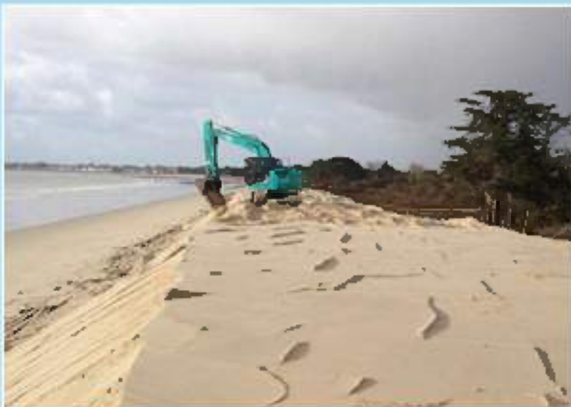
Figure 106 : travaux de confortement dunaire au Treustel en 2019.
