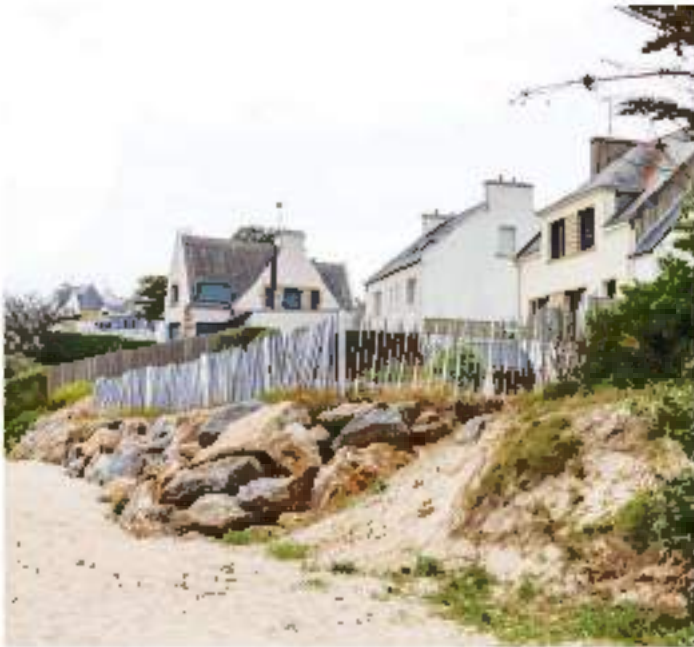
Figure 18 : ouvrages longitudinaux : en haut, en enrochements, plage de Trescaderc, Audierne ; en bas : en big bags, plage de la Grève Rose, Trégastel.
