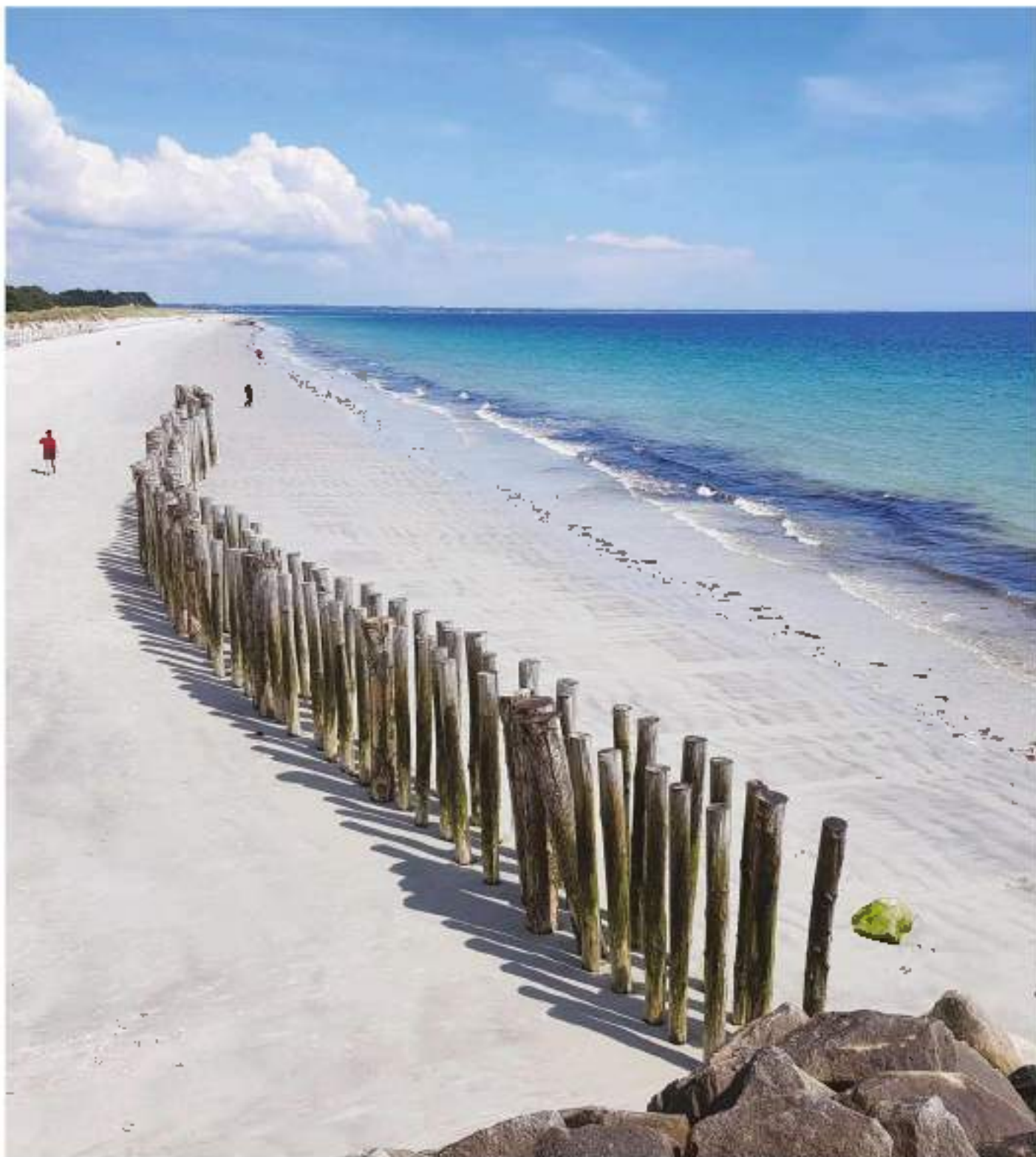
Figure 2 : pieux hydrauliques implantés sur la plage de Cleut-Rouz à Fouesnant en 2019.
