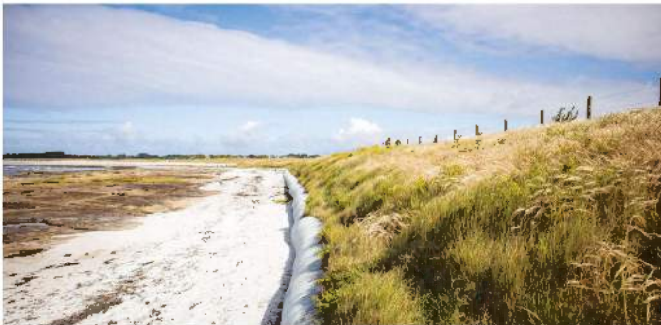
Figure 21 : ouvrage en boudin géotextile en pied de dune, la Grève-Blanche au Guilvinec.
