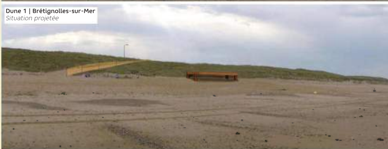
Figure 176 : situation avant et après la dépose des enrochements de « Dunes 1 », à Brétignolles-sur-mer (85). (d'après Communauté de communes du Pays de Saint-Gilles-Croix-de-Vie, 2021)
