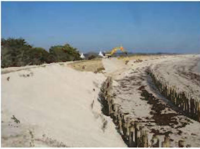
Figure 103 : confortement de la dune de Léhan à Treffiagat.
