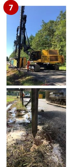
7 Stabilisation chimique du sol sous chaussée par injection du Remediate Clay®
