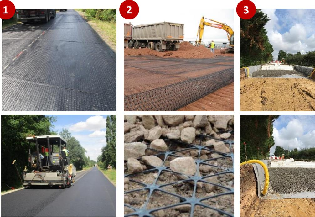
1 Réhabilitation de l'enrobé avec le principe du Recyclovia® (seul et renforcé par une géogridle)
