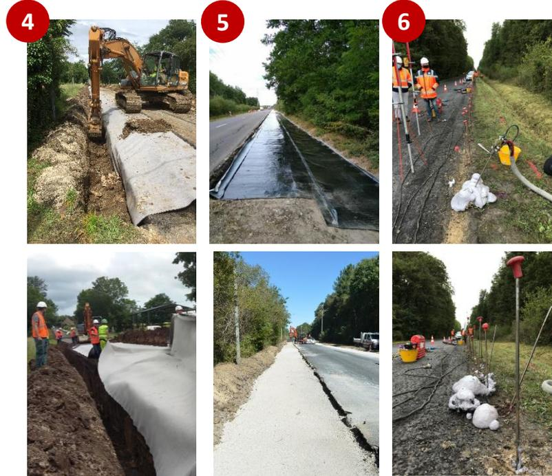
4 Étanchéification verticale par encapsulage avec une géomembrane
