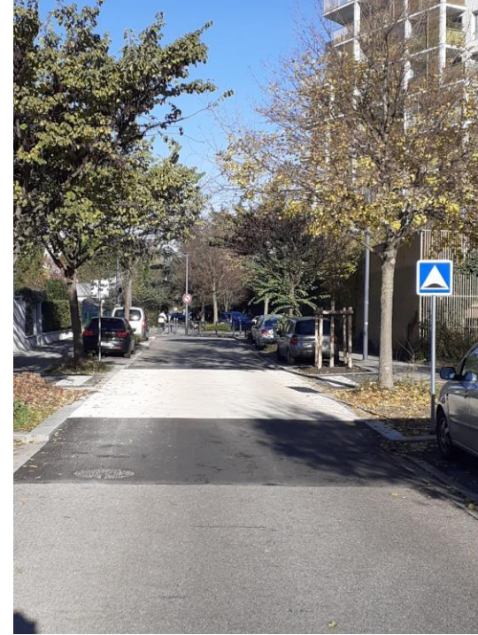
Nouvelle traversée piétonne sur plateau
