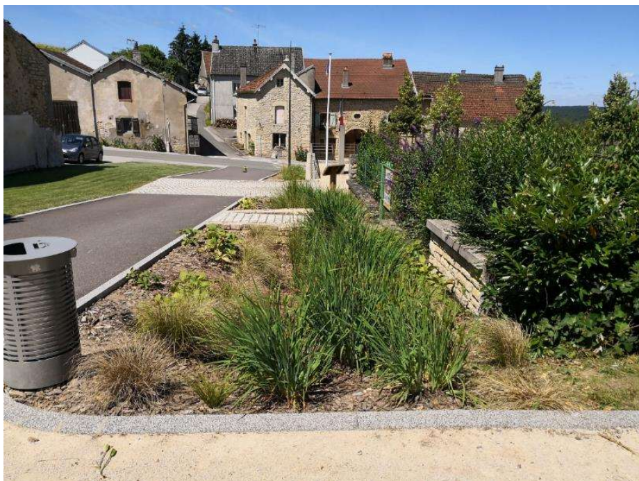
Requalification du centre bourg – Saint-Rémy en Comté
