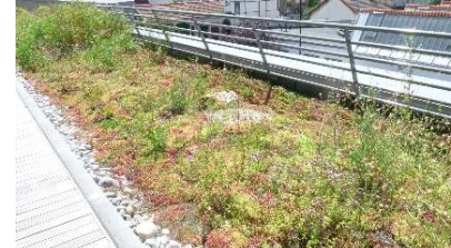
Toitures végétalisées (>8cm)
