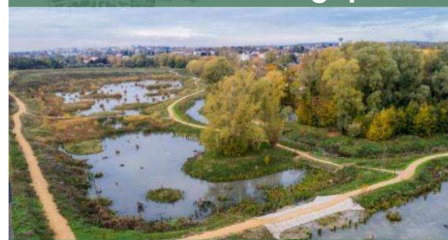
Gestion eau, inondation, ruissellement
